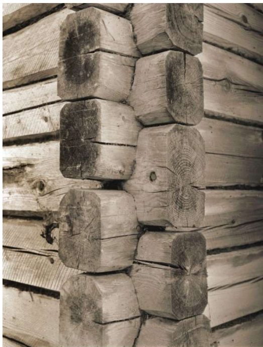
KUVA 1. Esimerkki nurkkasalvoksesta (Korhonen 2016)
