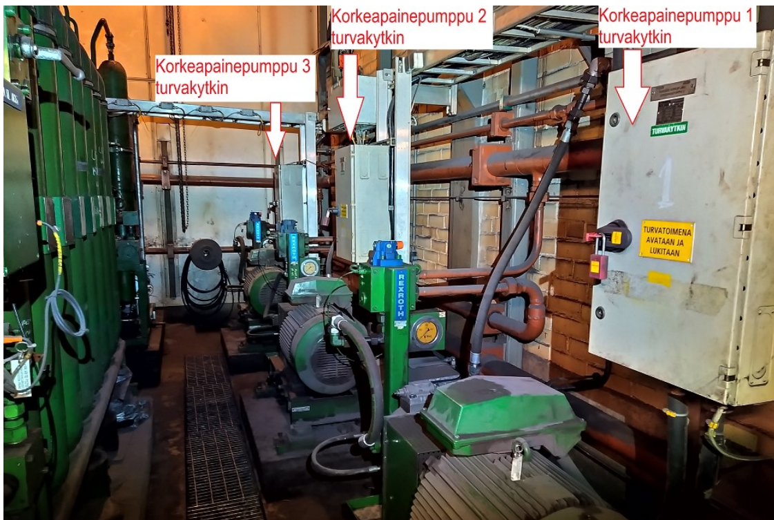
KUVA 9. Hydraulikkatilan turvakytkimiä
