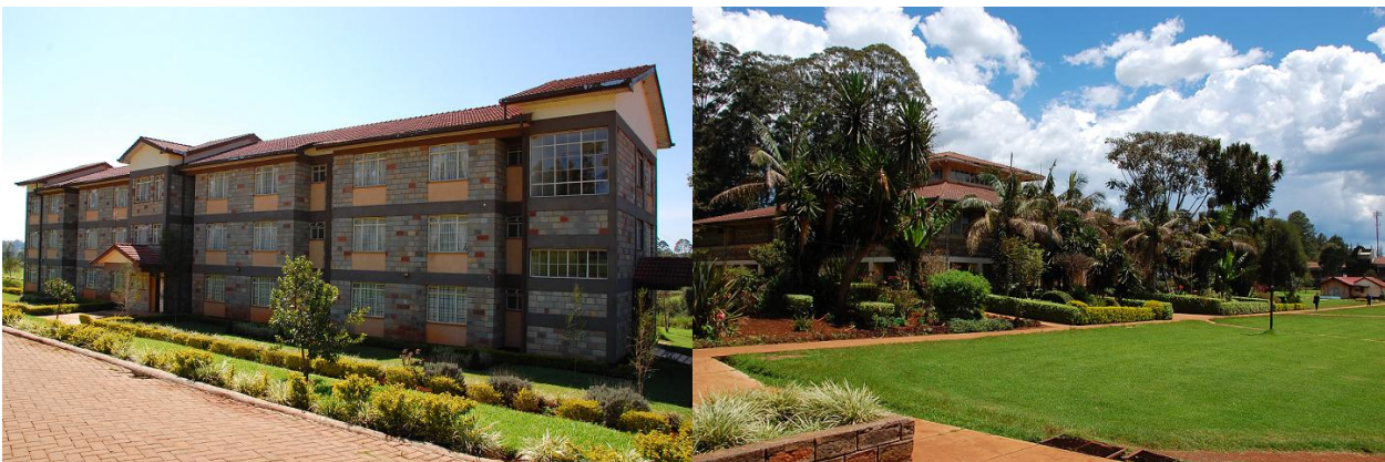
Kuva 10. Guest House ja Cafeteria Building palmujen katveessa
