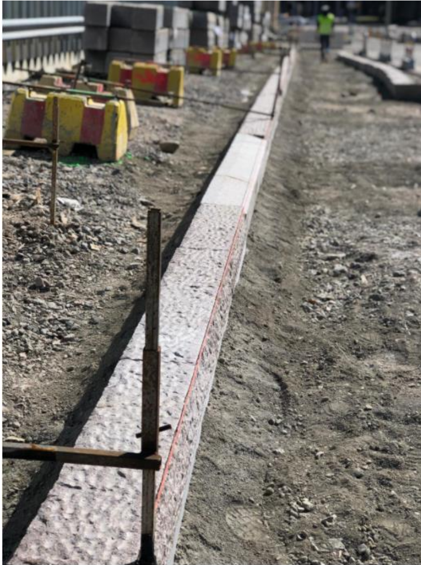
KUVA 14. Linjakeppejä korvaavat betoniporsaat reunakiviasennuksessa
