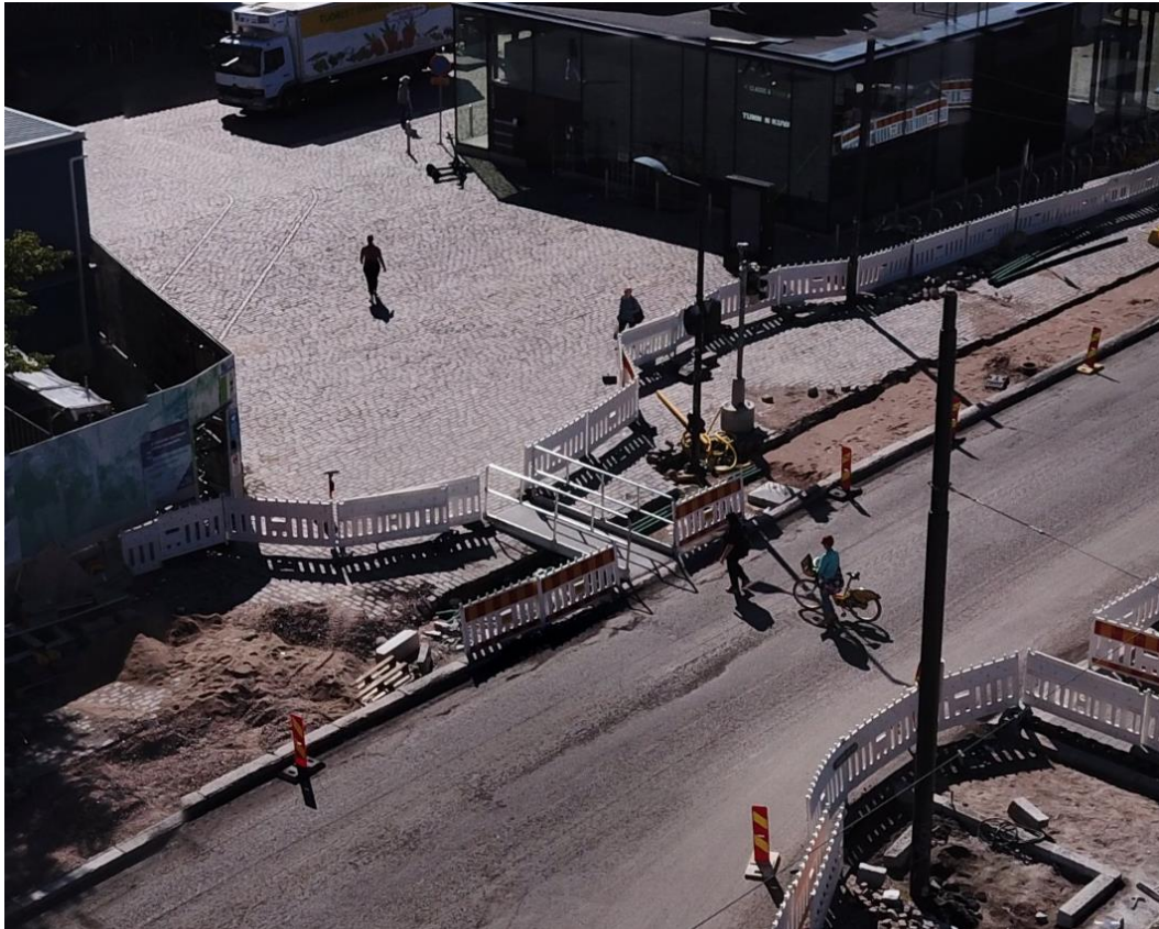
KUVA 15. Alumiinisen kulkusillan käyttö osana liikennejärjestelyitä (Destia 2020)
