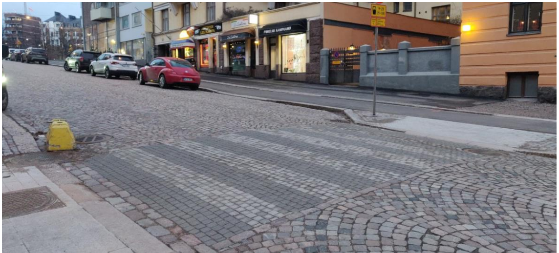
KUVA 10. Vanhan ja uuden kiven käyttö katurakenteessa (Hyvärinen 2020)
