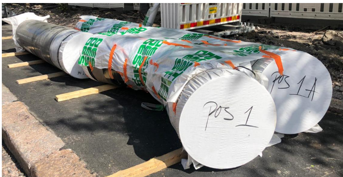
KUVA 6. Vesihuollon materiaalien säilytys työkohteessa
