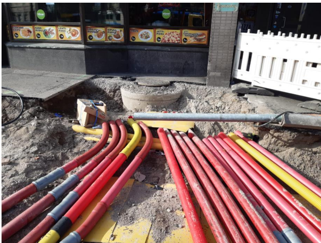
KUVA 7. Hämeentien suojaputket ovat useamman YKT-osapuolen omistamaa (Sulkama 2020)
