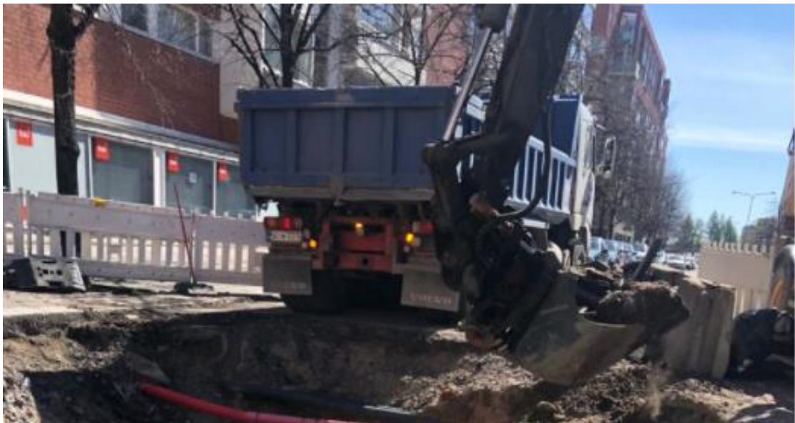
KUVA 8. Maankaivua suoraan auton kyytiin
