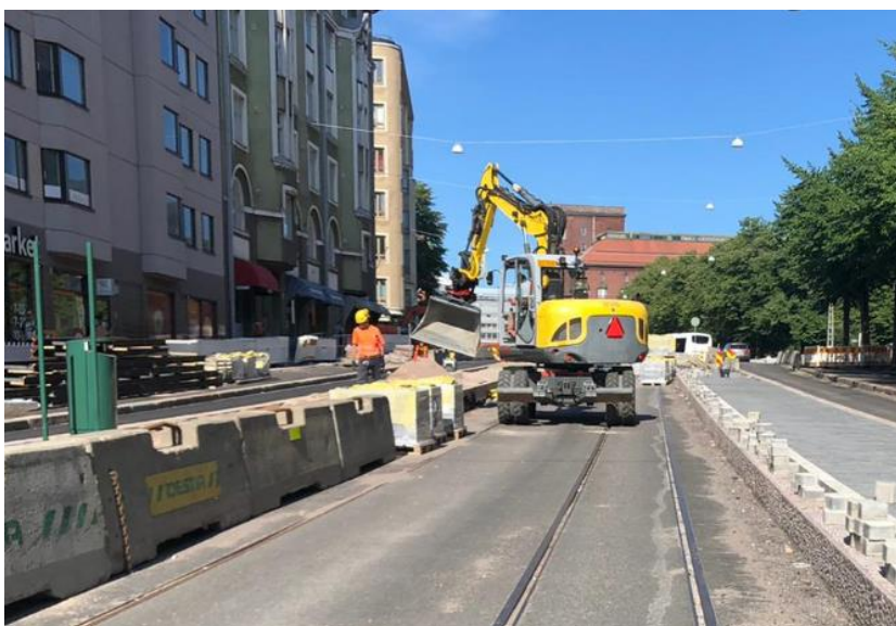
KUVA 9. Esimerkki urakan ylimääräisestä pyöräalustaisesta kaivinkoneesta
