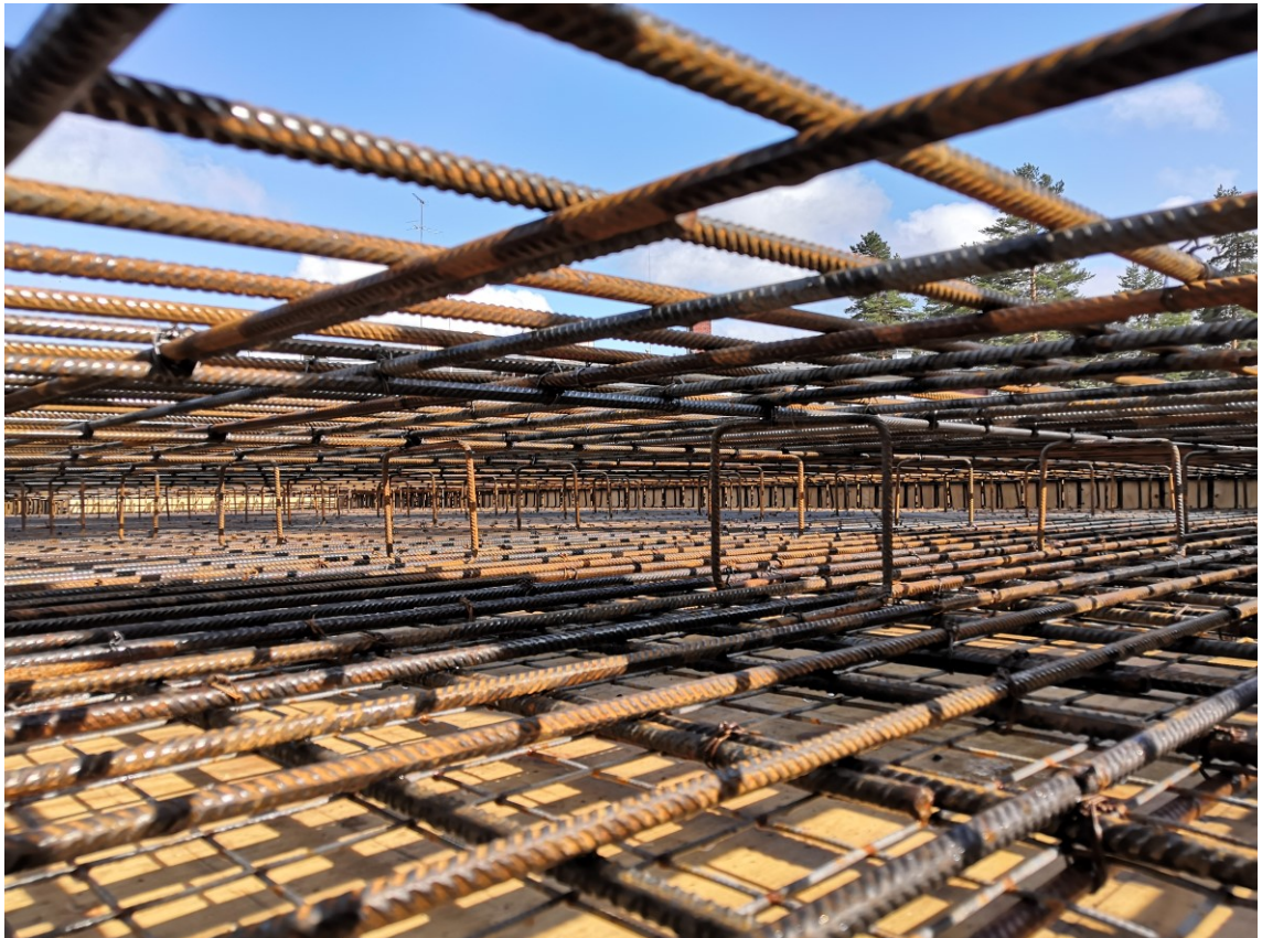
KUVA 2. Väestönsuojaholvin raudoitusta
