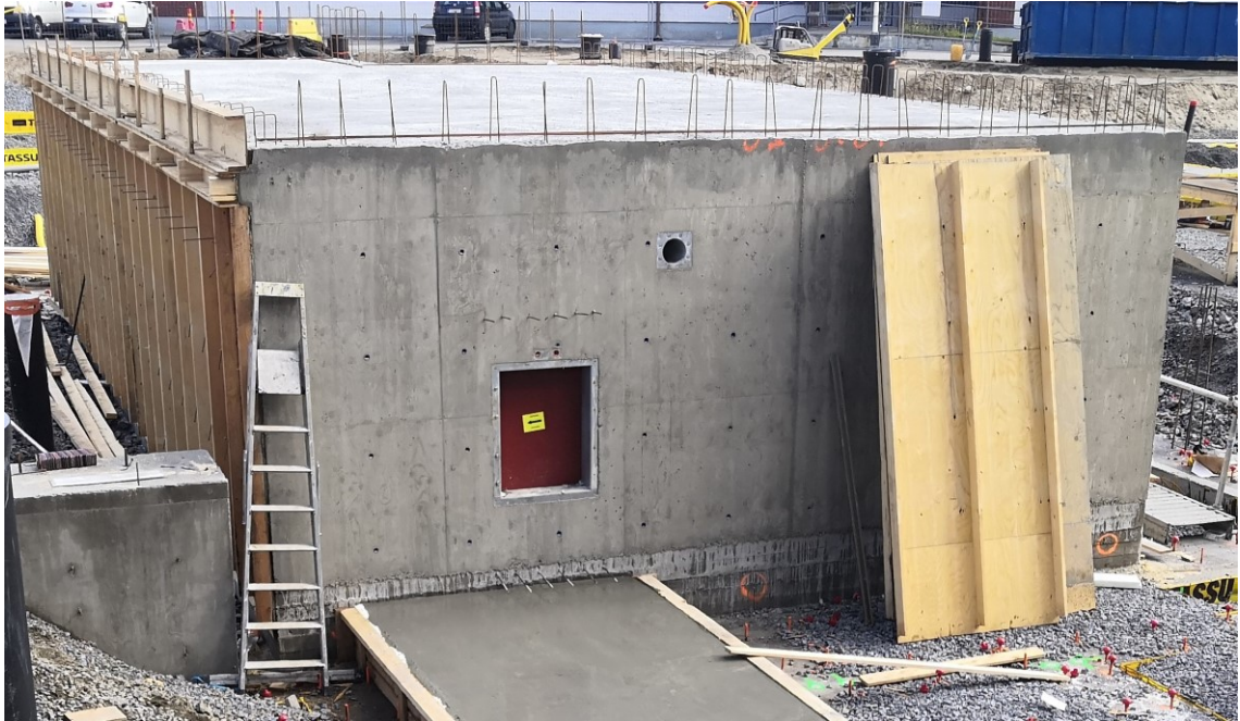
KUVA 1. Paikallavalettu S1-luokan teräsbetoniväestönsuoja
