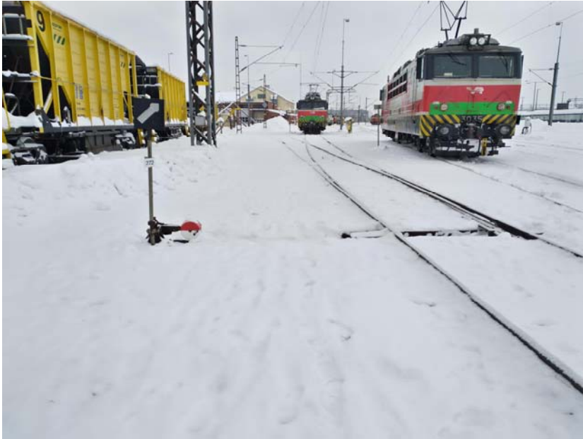
KUVA 9. Yksinkertainen vaihde käsiasettimella ja suuntanuolella
