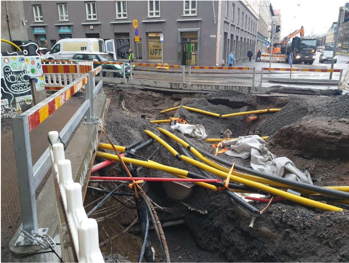
Kuva 2. Vanhoja kaapeleita Helsinginkadulla, vesihuoltolinjan rakentamisen edessä
