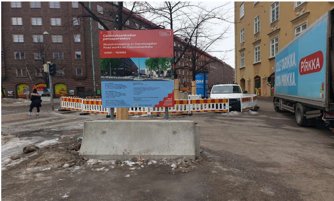
Kuva 6. Työmaataulun turvallinen sijoittaminen
