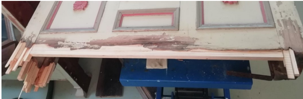
Kuva 22. Puukorjauksen korjaus (Lankiala 2021)
