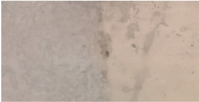
Kuva 17. Kuivapuhdistettu vas. märkäpuhdistettu oik. (Lankiala 2021)
