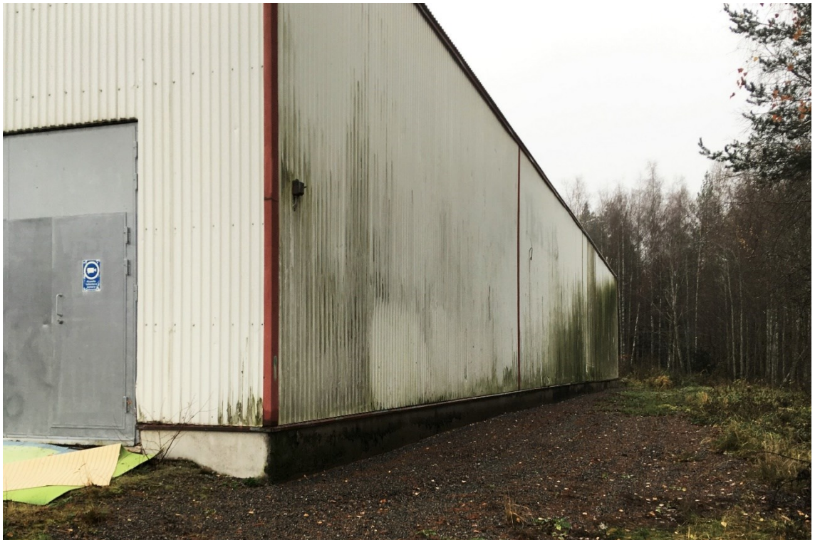
KUVA 11. Kulumaa tennishallin julkisivuissa
