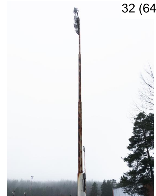
Pahoin ruostunut pesäpallokentän valaisinylvyt
