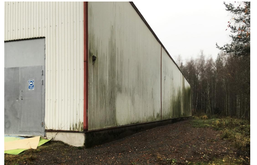
Kulmaa tennishallin julkisivuissa
