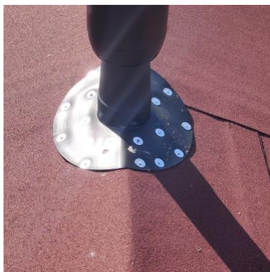
Kuva 17. Alipainetuulettimen kiinnittäminen.
