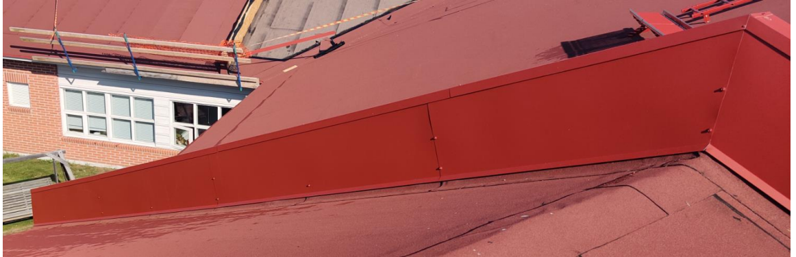
Kuva 35. Palokatko bitumikermikatolla.
