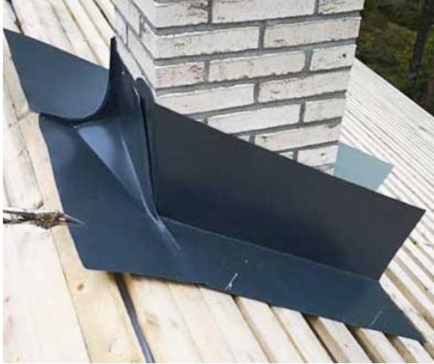
Kuva 47. Kallistus ohjaa veden pois piipun takaa [42.]
