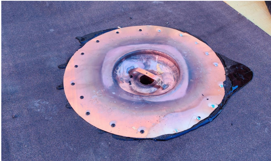
Kuva 28. Kattokaivo kiinnitettyä alustaan ruuvein sekä kuumabitumilla.
