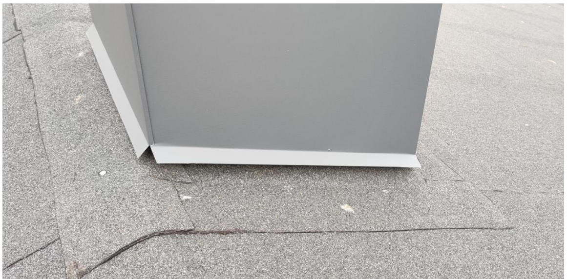
Kuva 25. Oikean mittainen piipunpellitys.
