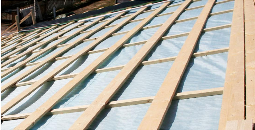
kuva 39. Tuuletusrima aluskatteen ja ruoteiden välissä [33.]
