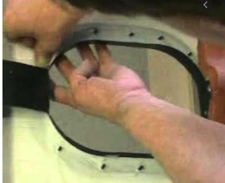
Kuva 43. Aluskatteeseen asennettava aluskaterengas mahdollistaa hyvän toteutuksen [37.]
