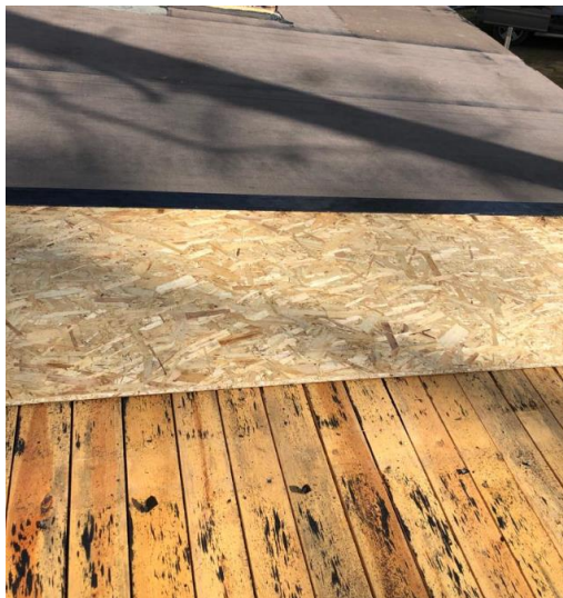
Kuva 11. OSB-levy raakapontin päällä.
