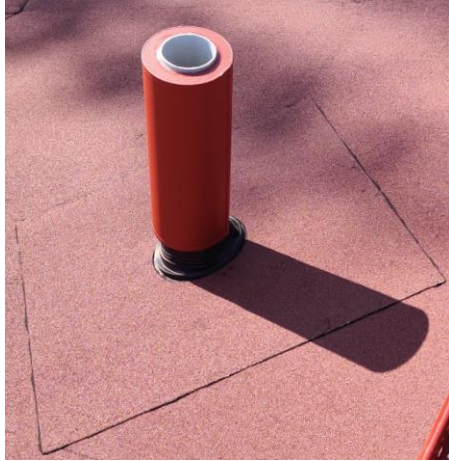
Kuva 22. Tiivistetty viemärintuuletusputki pakkasmanttelilla.
