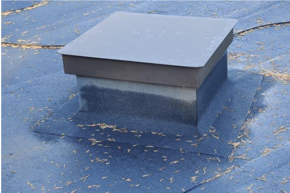
Kuva 26. Valmis kattoluukku.
