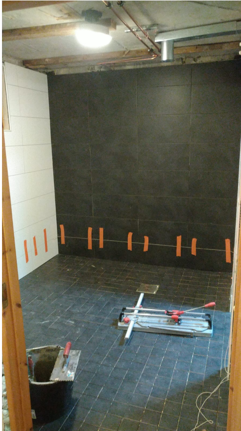
Kuvat 6. Kuvassa laatoitustyöt tehtyinä.
