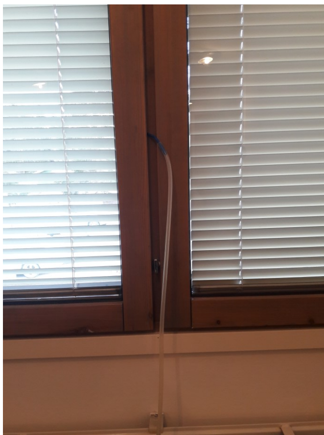
Kuva 15. Paine-eromittaus ulko- ja sisäilman välillä.
