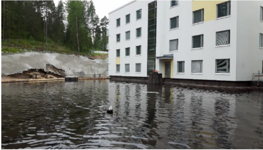
Kuva 6 Vedeneristyksen vesipainekoe kansilaatalla
