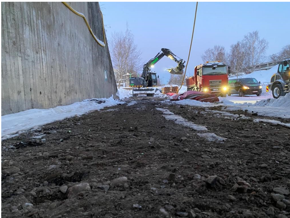
Kuva 1 Hankkeella työtehtävissä oleva Kaivuupalvelun 18 tn kaivinkone, sekä 5 akselinen kuorma-auto
