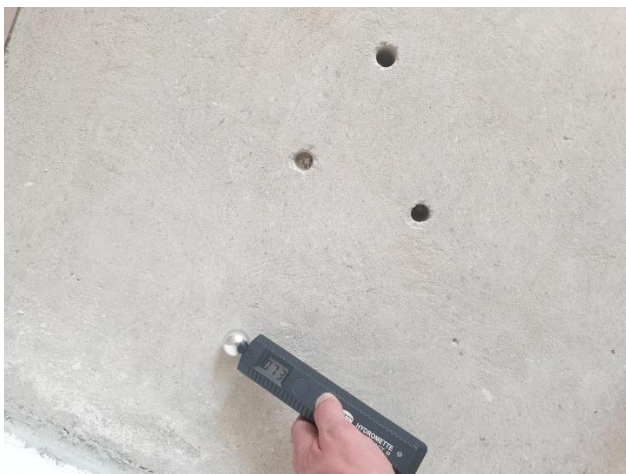
Kuva 4. Rakenteen kosteusmittaus pintakosteusmittarilla.
