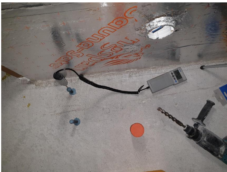
Kuva 5. Suojaputket tiivistetty ja mittapää laitettu tasaantumaan suojaputkeen.
