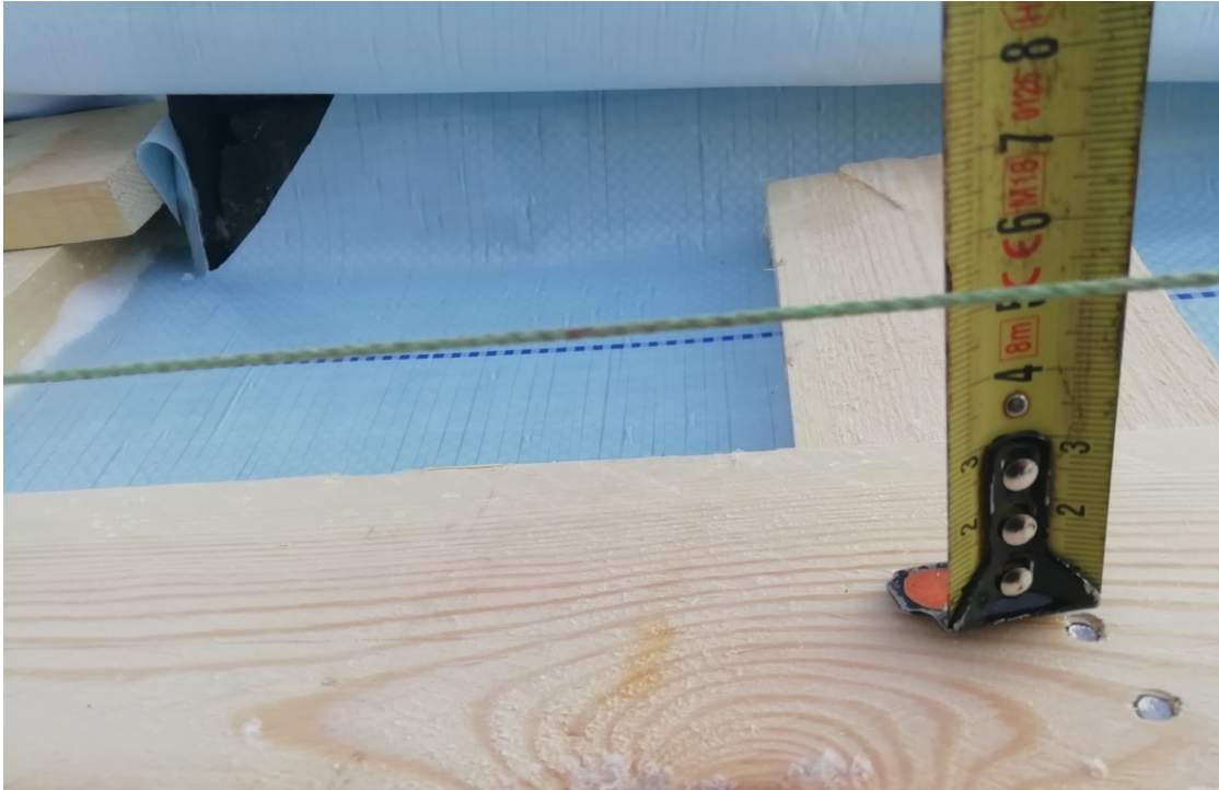
KUVA 13 Tarkastusmittaus
