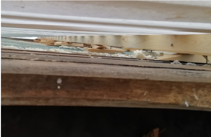
KUVA 19 Kiinnittämätön kiila
