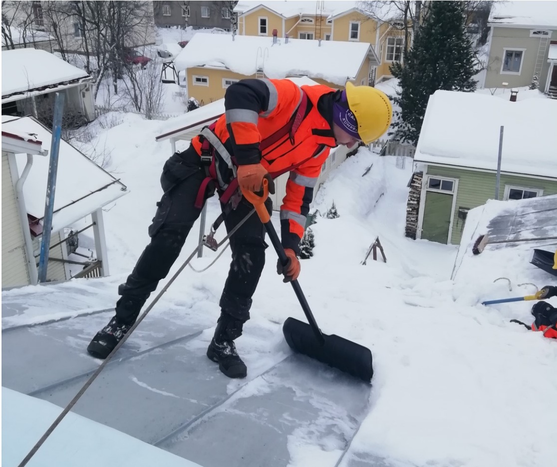
KUVA 7 Lumi pudotettiin katolta lapioimalla, turvavaljaita käyttäen.
