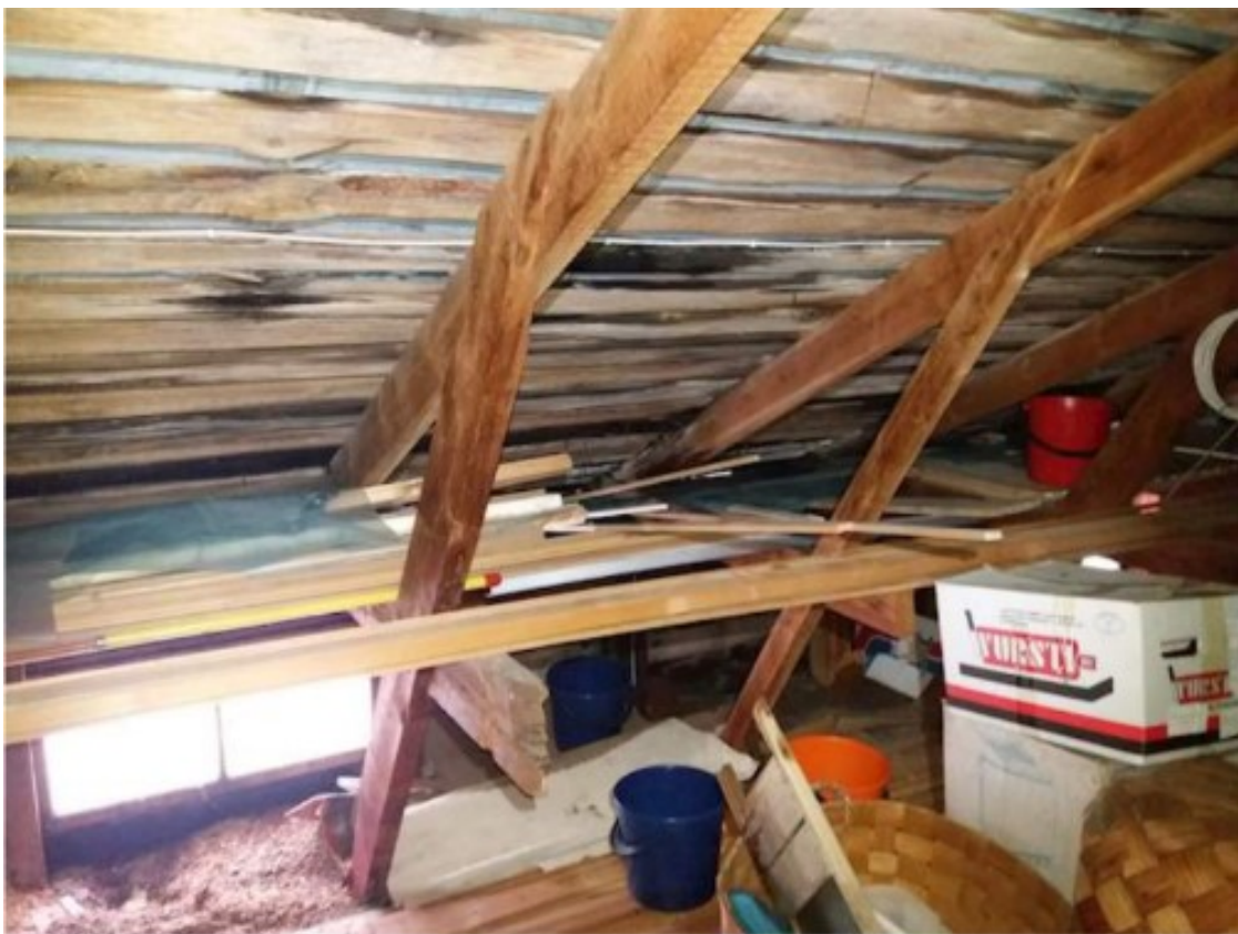
KUVA 5 Ruotsalainen ristikkorakenne.
