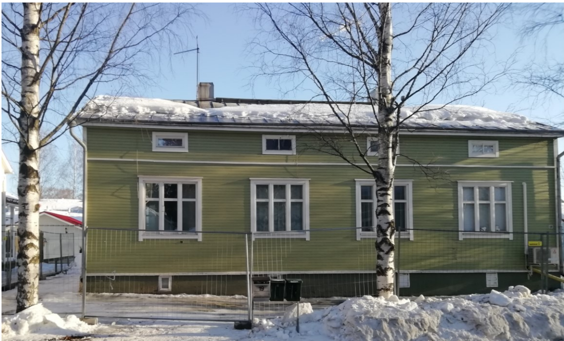
KUVA 4 Lunta kertyi jalkarännejä vasten aiheuttaen lumen jäätyminen paannejääksi.
