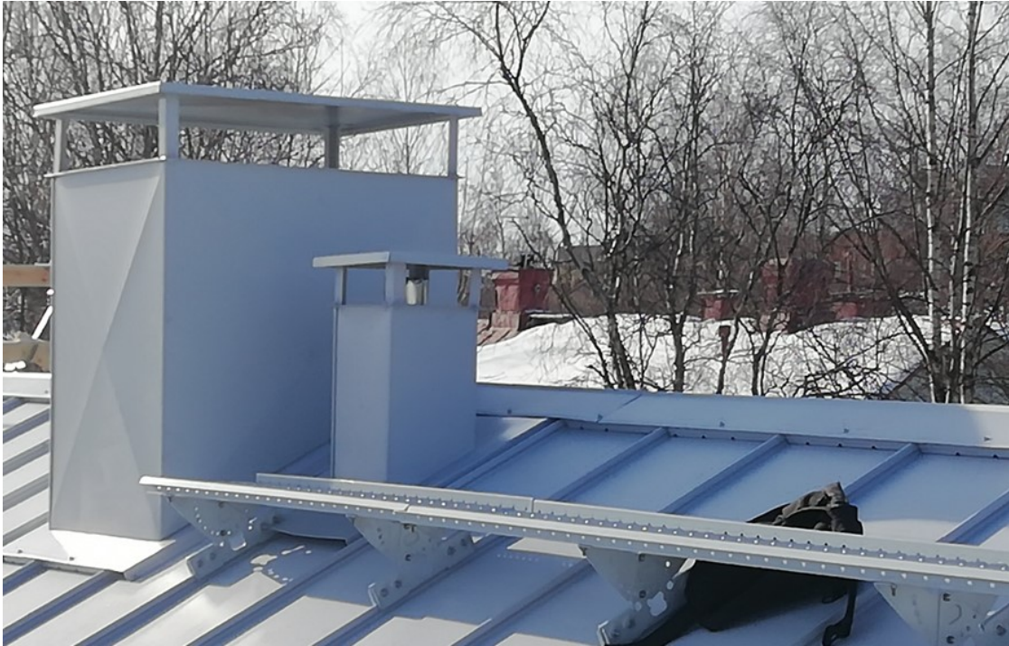
KUVA 14 Asennettiin kattoturva vaatimusten mukaiset lapetikkaat ja kulkusillat, sekä pellitettiin piiput ja läpiviennit.
