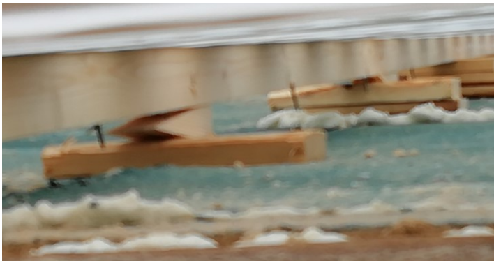
KUVA 20 Ohiammutut ja tyhjän päällä olevat naulat
