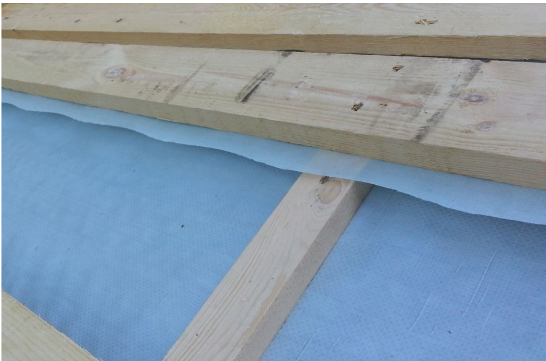
KUVA 11 Tuplatuulettuva harja
