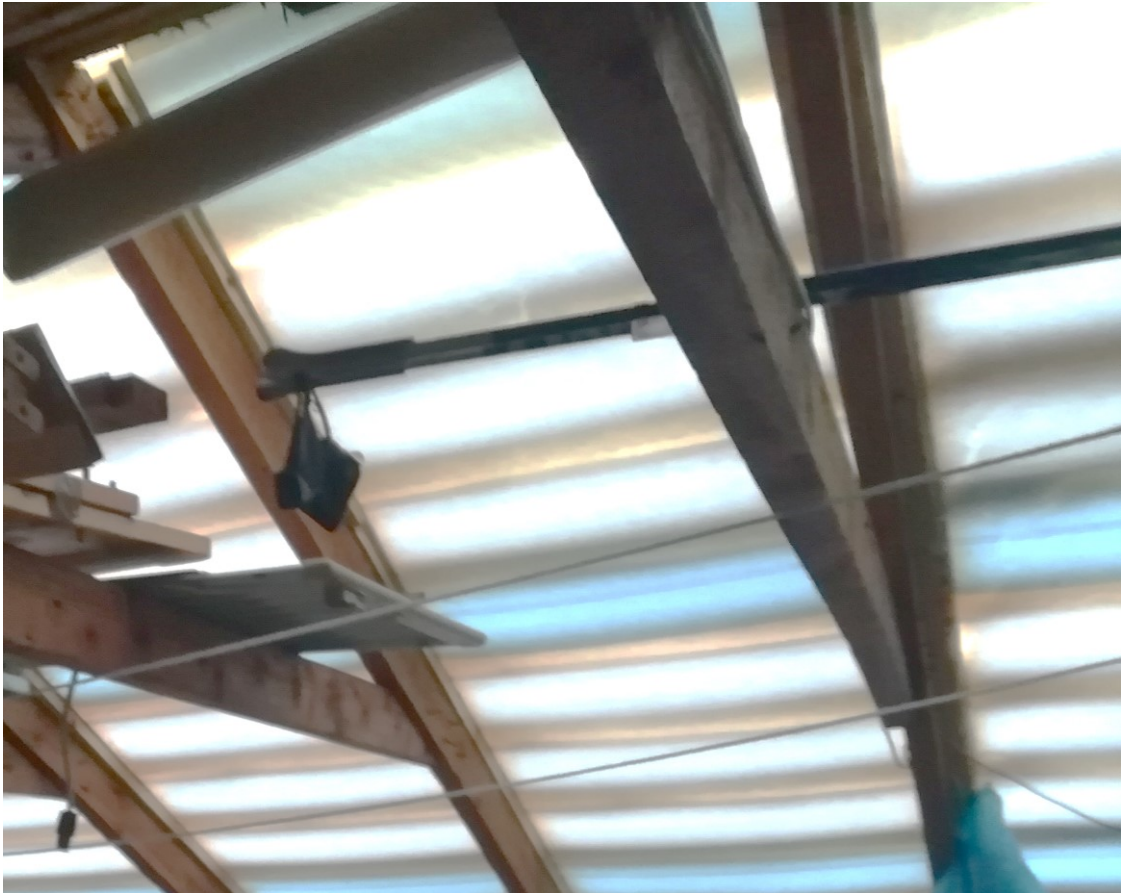
KUVA 9 Painumat oikaistiin korottamalla koolauslaudalla.
