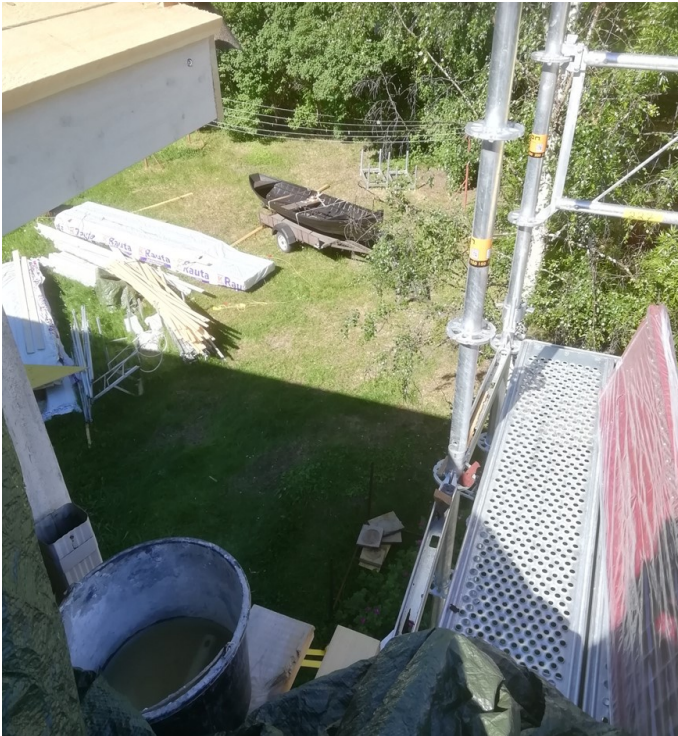
KUVA 16 Putoamissuojaus puuttuu.
