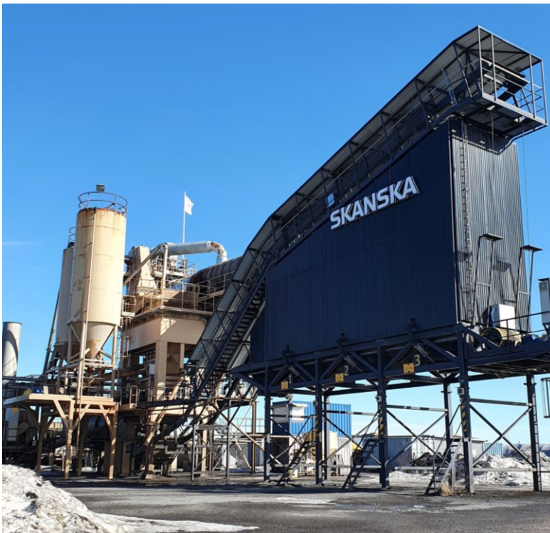
KUVA 3. Kuumamassasiiloilla varustettu asfalttiasema
