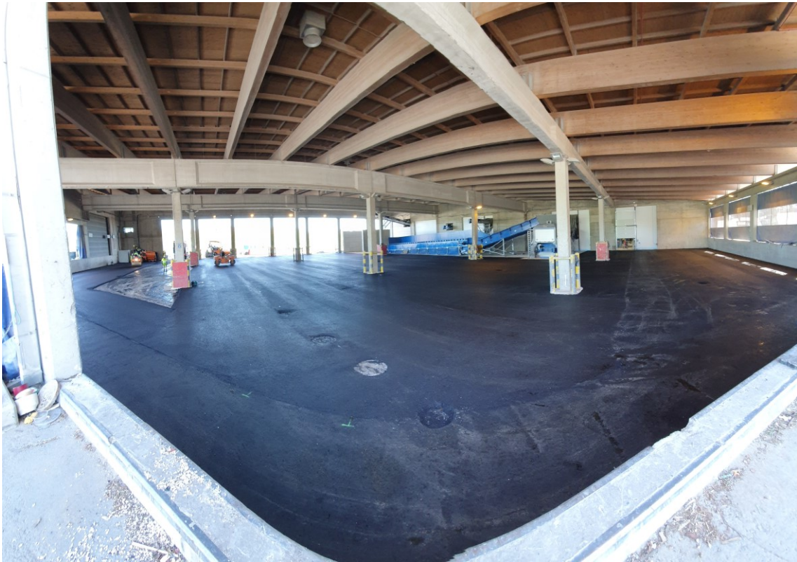
KUVA 7. Asfaltinpäällystys Oulun Energian lajitteluareenalla
