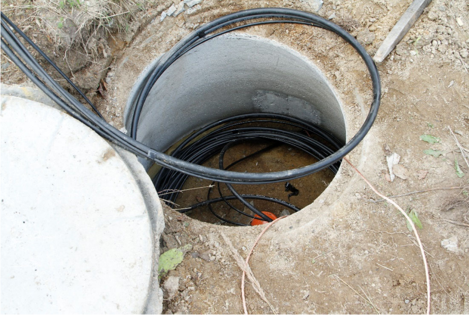
Kuva 6. Kuitujatkoksen sijoittaminen betoniseen kaivoon.
