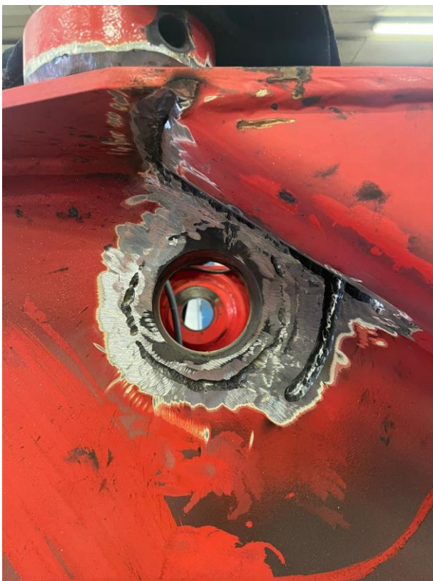
KUVA 19. Avattu ratkeama koneen rungossa
