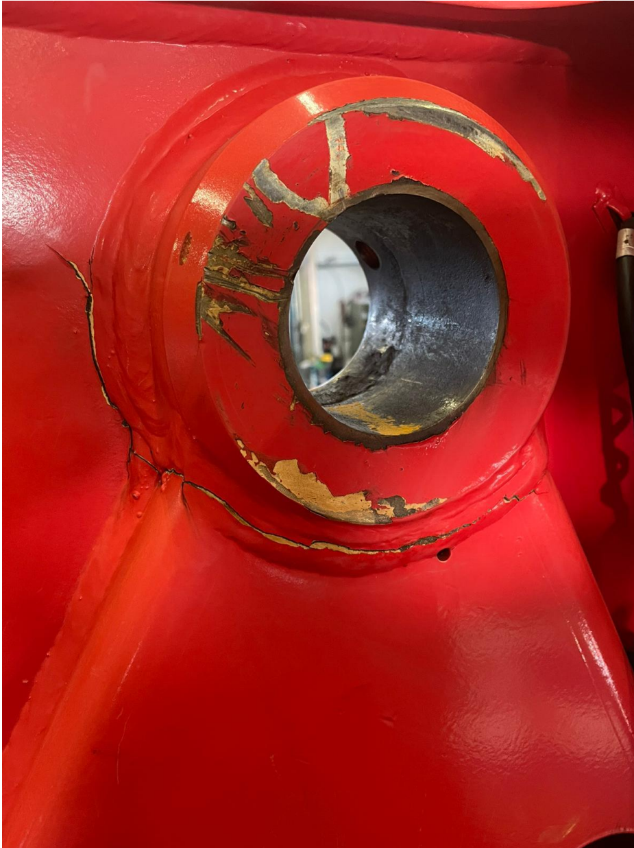
KUVA 18. Ratkeama koneen rungon sisäpinnalla
