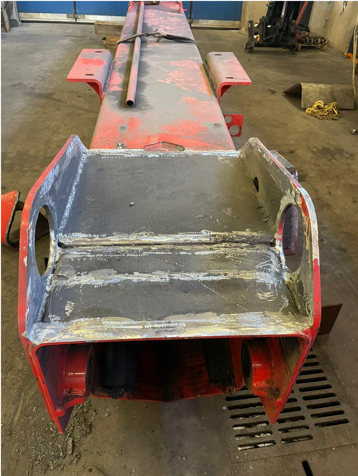
KUVA 22. Peruspuomi valmiina uusia kappaleita varten
