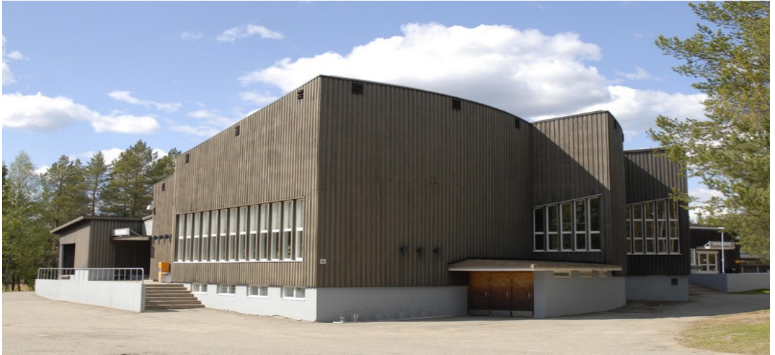
Kuva 1 Sodankylän sotilaskoti (Sodankylän sotilaskoti, 2010)
