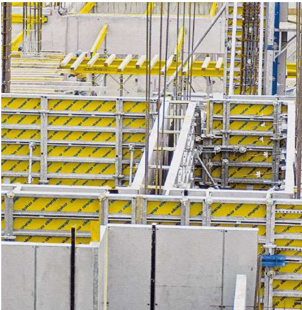
Kuva 1. Dokan järjestelmämuotti Framax Xlife. (Dokan www-sivut.)
