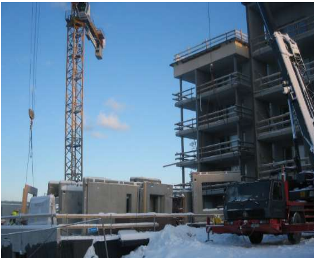
Kuva 4. Seinäelementin nosto torninosturilla (Betonielementtien nostot 2010, 7)
