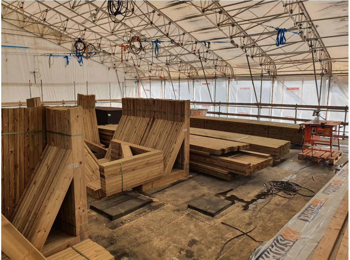
Kuva 2. Postiljoonin esivalmistetut räystäspukit varastoituna vesikatolle odottamaan asennustöitä. [5]
