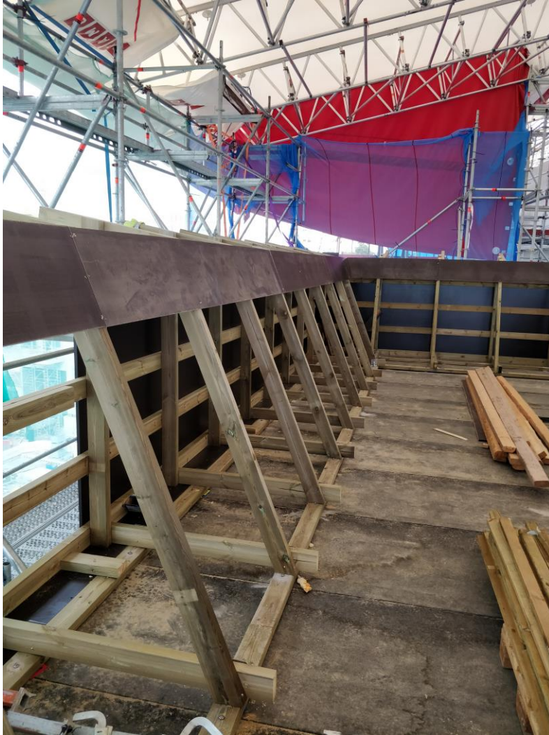
Kuva 10. Postimiehen paikalla tehty räystäspukki asennettuna. [5]
