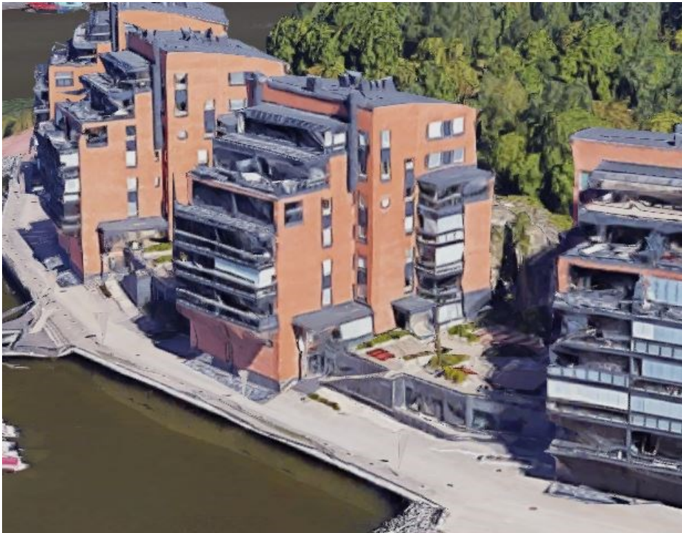
Kuva 8. Tarkasteltava asuinkerrostalo kuvattuna etelästä
