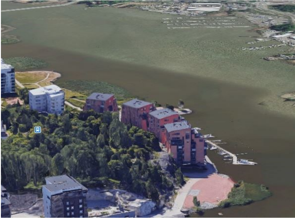
Kuva 7. Kortteli kuvattuna pohjoisesta
