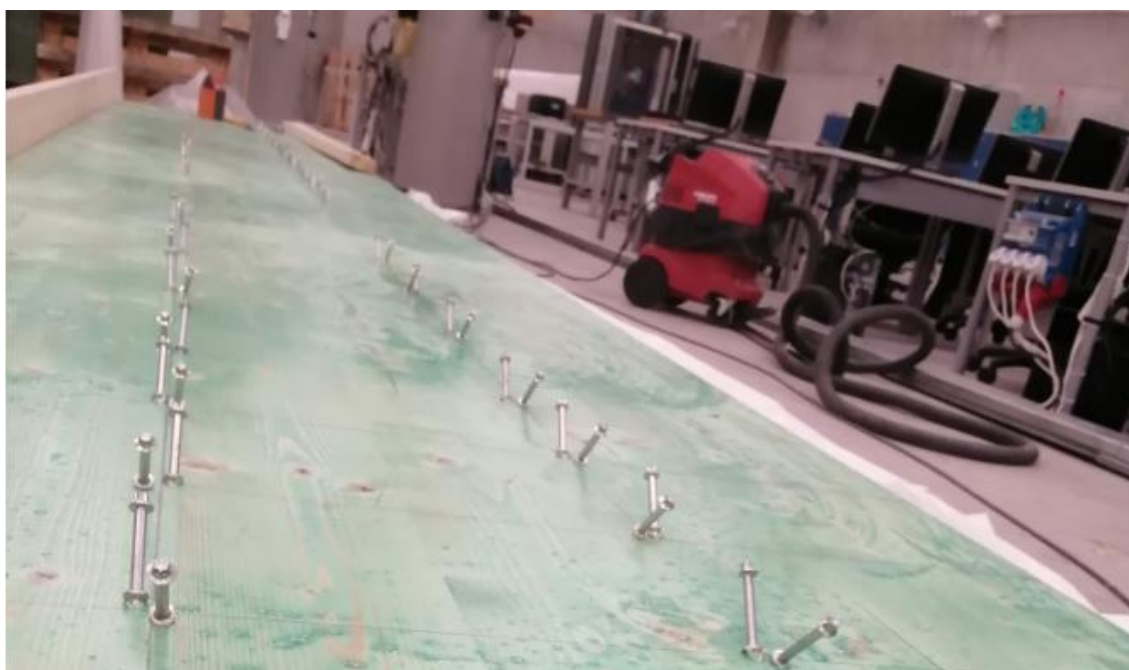
Kuva 4. Metropoliaassa rakennusfysiikan laboratoriossa valmistusvaiheessa oleva koerakenne. Liittoruuvit ruuvattuna ja CLT-laatta kosteuseristettynä, ennen betonin valamista.
