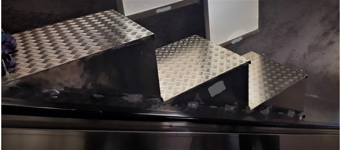
Kuva 17. Teline paikallaan liukuportaan reunapellillä.
