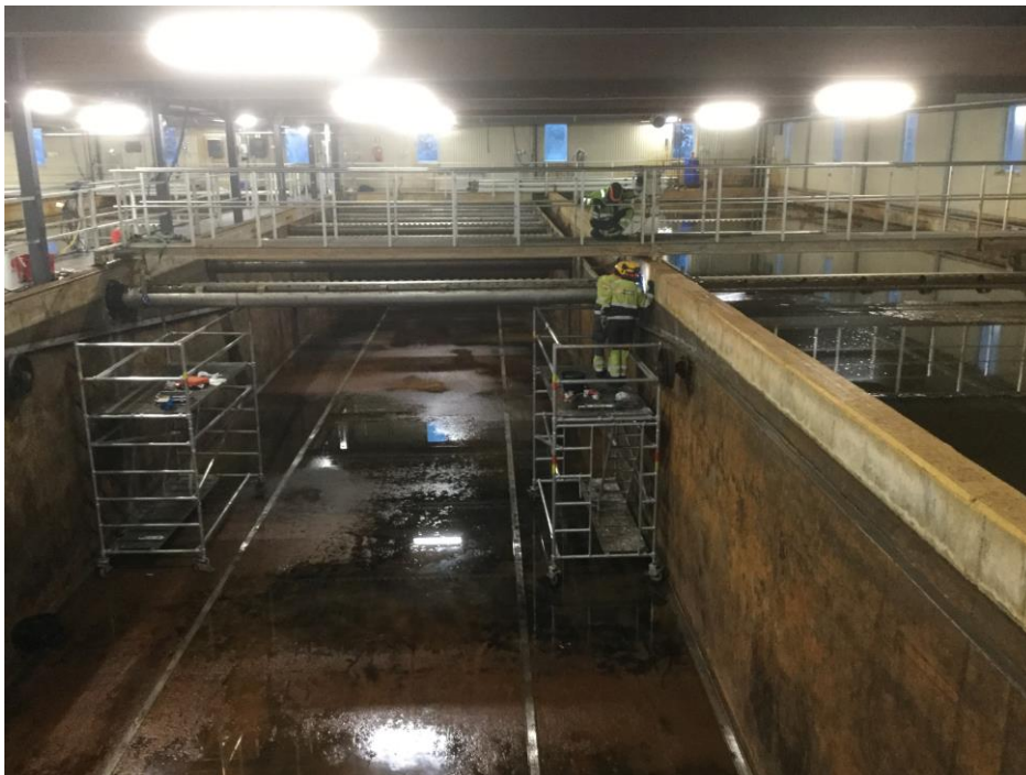
Kuva 3. Väliselkeytsaltaan lietekourun huoltotyö Kuhasalossa (Kuva: Väinö Rintala).
