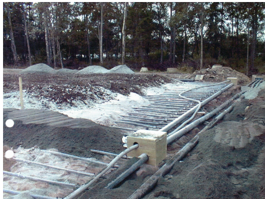
Kuva 1. Maalämmitysputkistoa asennetaan Olkiluodossa. Kuva: Jukka Huttunen
