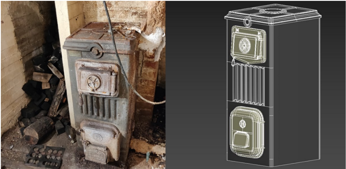
Kuva 13. Kuvan pohjalta mallinnettu lämmitysuuni
