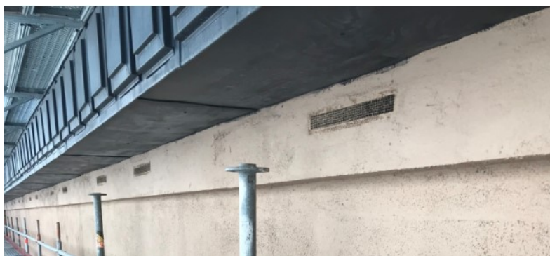
Kuva 16. Säilytetty vesikourun koristepellitys.
