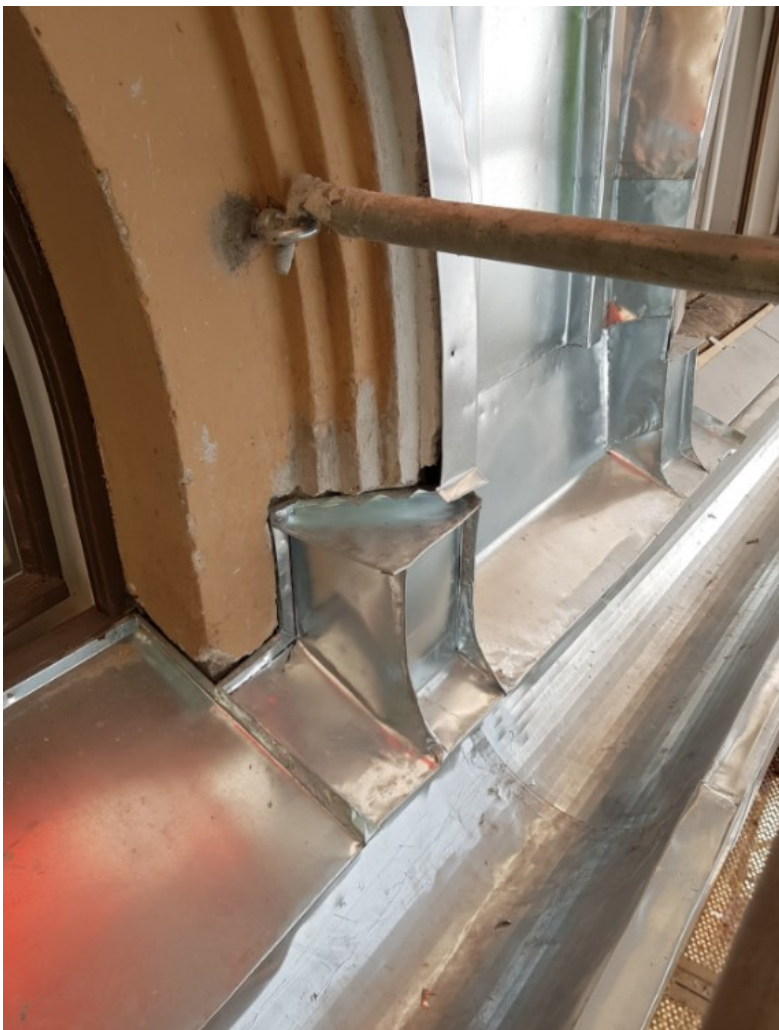
Kuva 22. Uudet vesikouruun, ikkunaan ja rappaukseen liittyvät pellitykset
