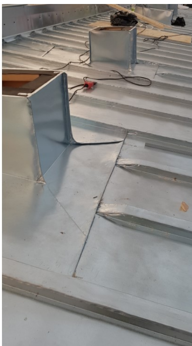
Kuva 31. Rimat päätettyä läpivienttiin
