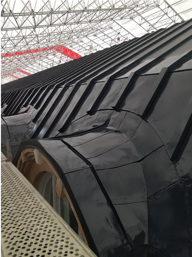
Kuva 40. Peltikatto juuri maalattuna sääsuojan alla
