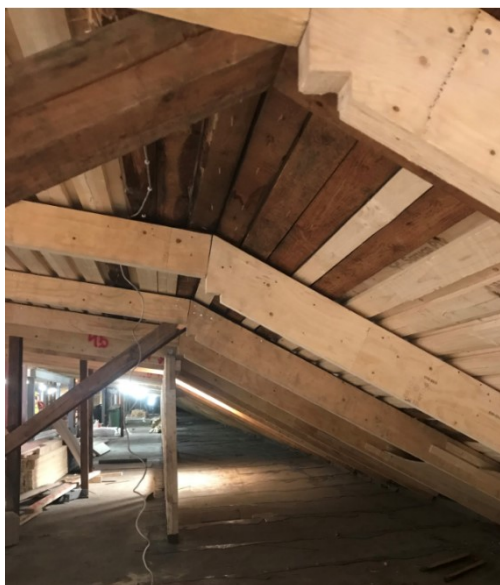
Kuva 17. Kertopuilla vahvistetut kattokannakkeet sekä vaihdettuja aluslaudoituksia C-lohkolla.
