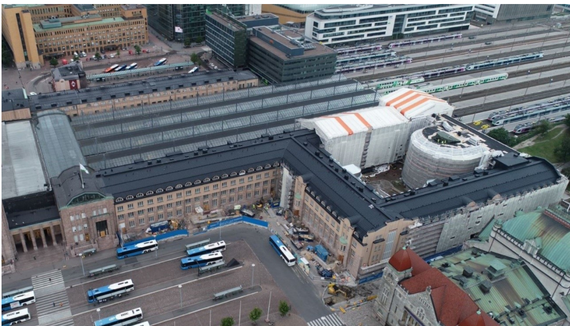
Kuva 14. Hotellityömaa kesällä 2020, kun suurin osa vesikatosta on uusittu (NCC 2020)
