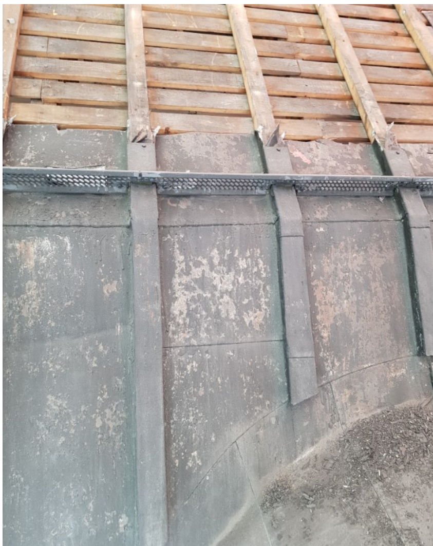
Kuva 32. Vanhojen rimojen päättyminen kaari-ikkunan kaareen ei ole veden pitävä ratkaisu
