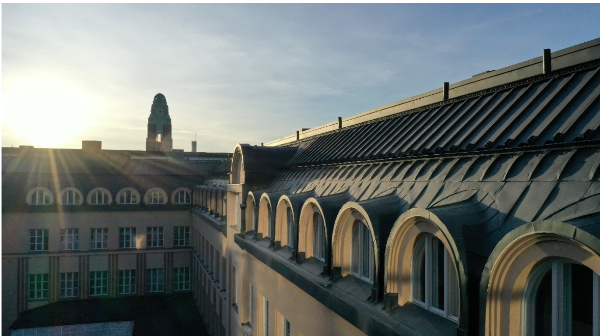
Kuva 41. D-lohko sisäpihan puolella (Broofing Oy 2020)
