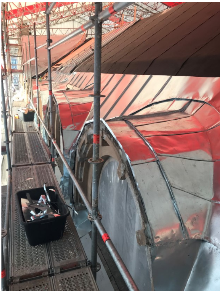
Kuva 26. Uusittu kaari-ikkunan pellitys
