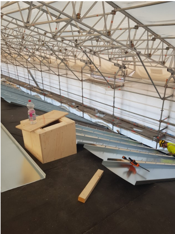
Kuva 29. Rimasaumapeltirivien asennusta
