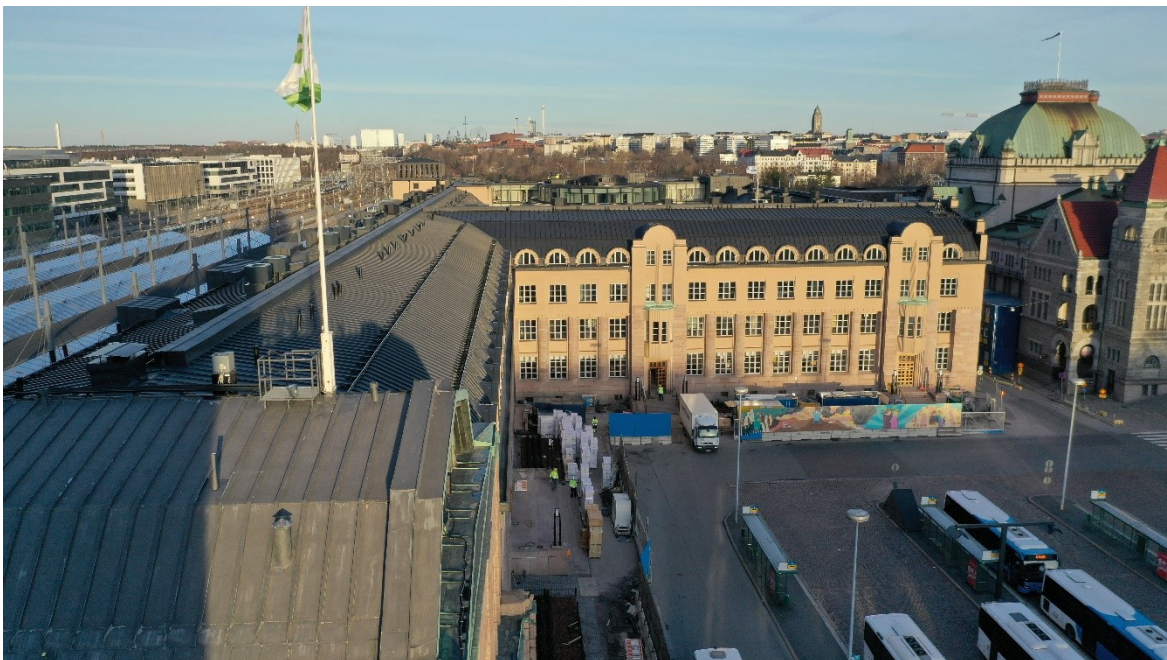
Kuva 42. C- ja E-lohko Rautatien aseman puolelta (Broofing Oy 2020)
