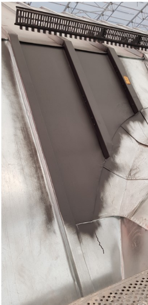
Kuva 33. Malli rimakotelon asennuksesta. Peltikotelon alla vedenpitävä rivisauma, jossa rivisaumaan tarkoitettu lumiestekannake kiinni ja johon kotelo on kiinnitetty pulteilla.
