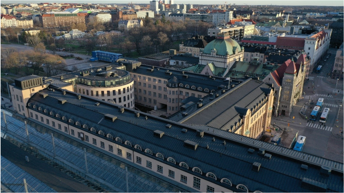
Kuva 44. Koko rakennuksen vesikatto valmiina (Broofing Oy 2020)
