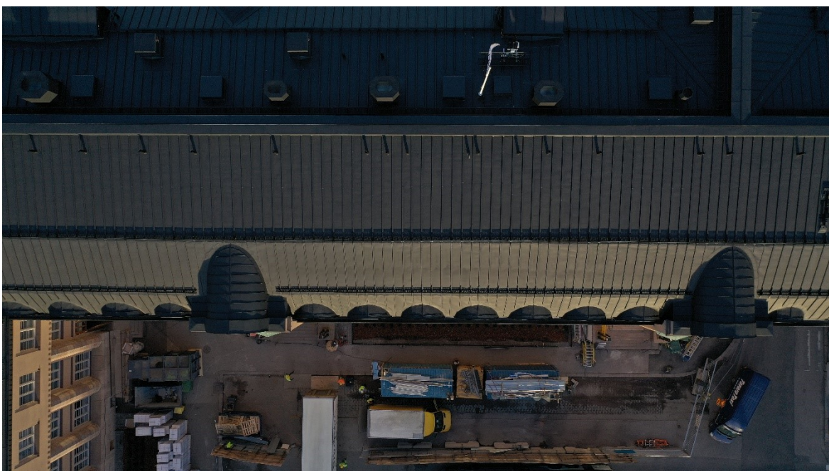
Kuva 43. E-lohkon rimasaumajako (Broofing Oy 2020)
