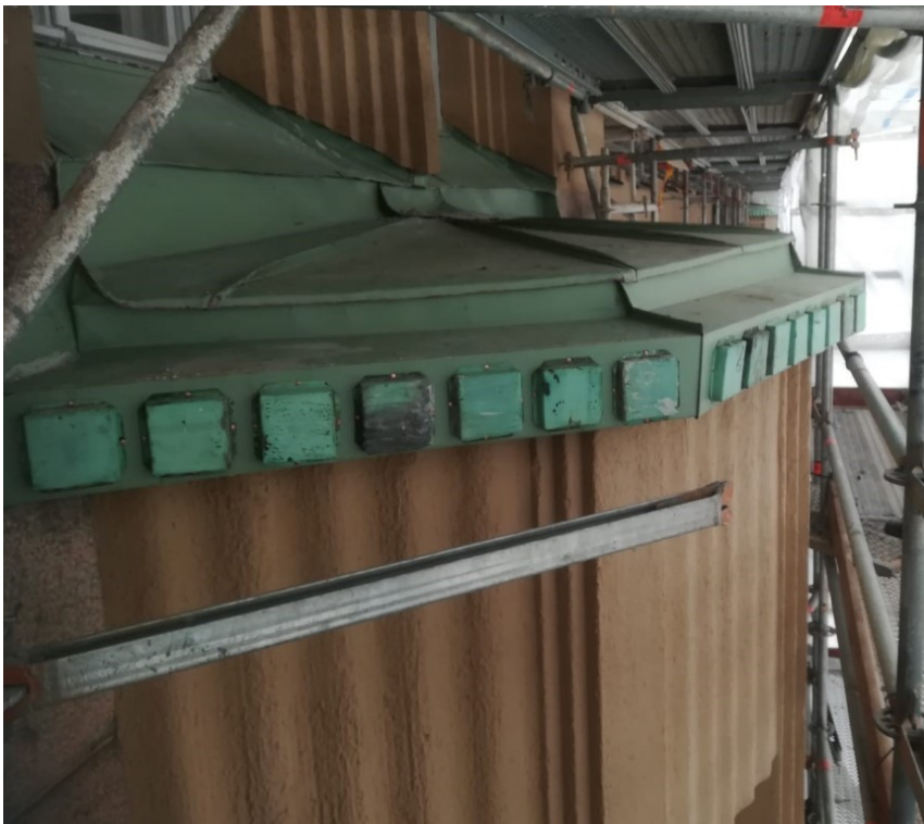
Kuva 39. Kuparierkkeri uusittuna sekä vanhat alkuperäiset kuparikoristeet asennettuna
