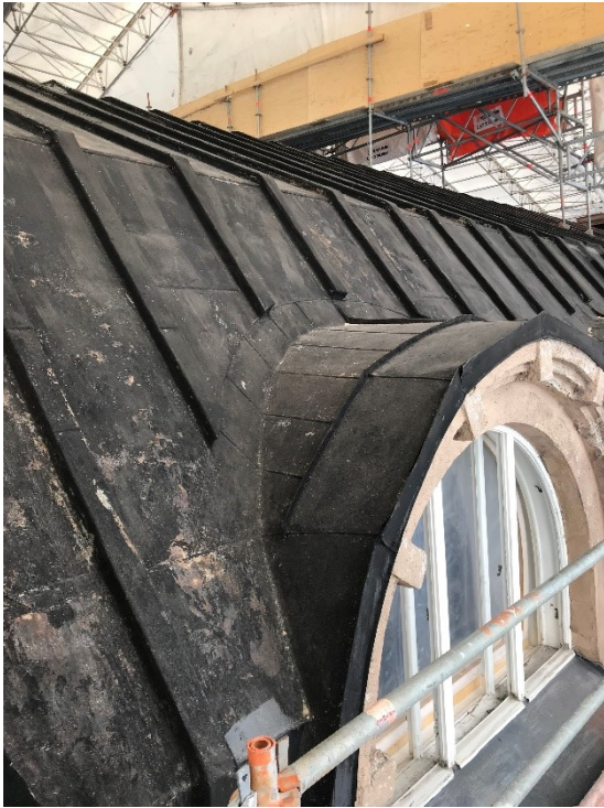
Kuva 23. Kulmikkaampi ja kaksiosainen pellitys. Rima jatkuu ikkunoiden väleissä.
