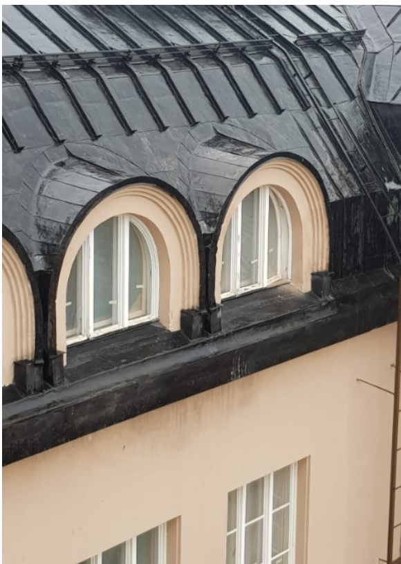
Kuva 24. Suoralinjaisempi ja viuhkamainen pellitys. Kaari-ikkunat melkein kiinni toisistaan.
