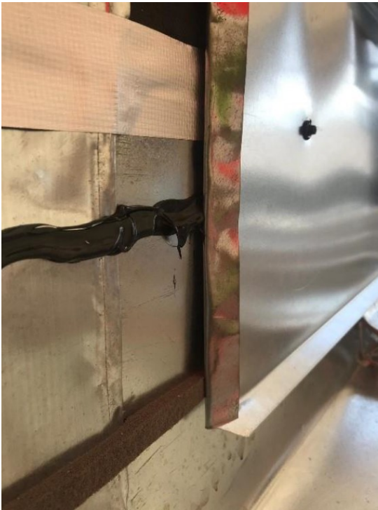
Kuva 35. Harjakotelon ylösnoston tiiveyden varmistus paisuntanauhalla ja tiivistysmassalla
