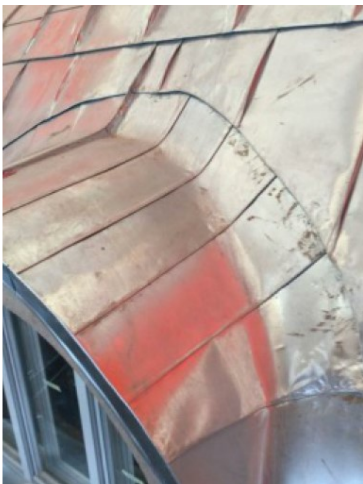
Kuva 25. Uusittu kaari-ikkunan pellitys
