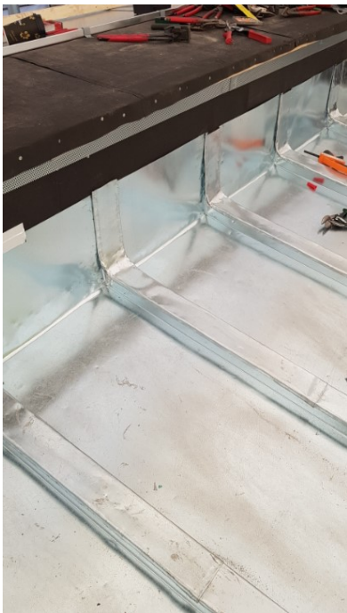
Kuva 30. Rimat päätettyä harjakammioon
