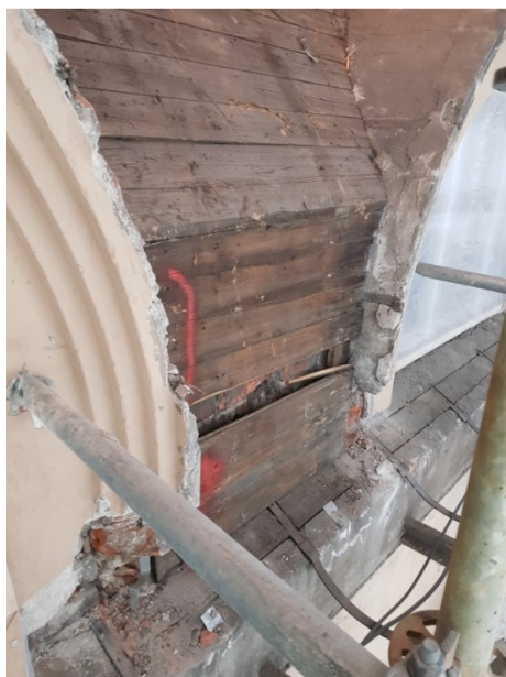
Kuva 18. Kaari-ikkunoiden välinen huonokuntoinen laudoitus uusittiin ja rakenteen tuuletus varmistettiin kourusta harjalle asti.
