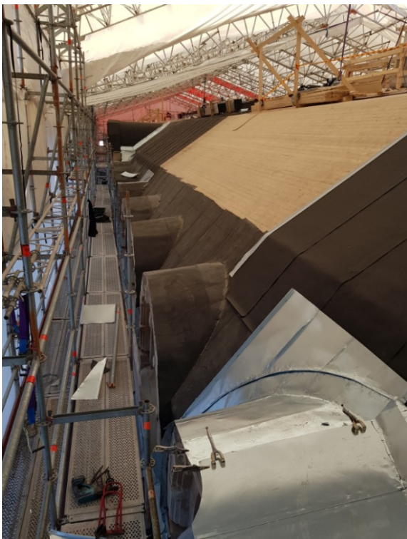
Kuva 20. Aluskate asennettuna kaari-ikkunoiden päälle ja liitossauma.
