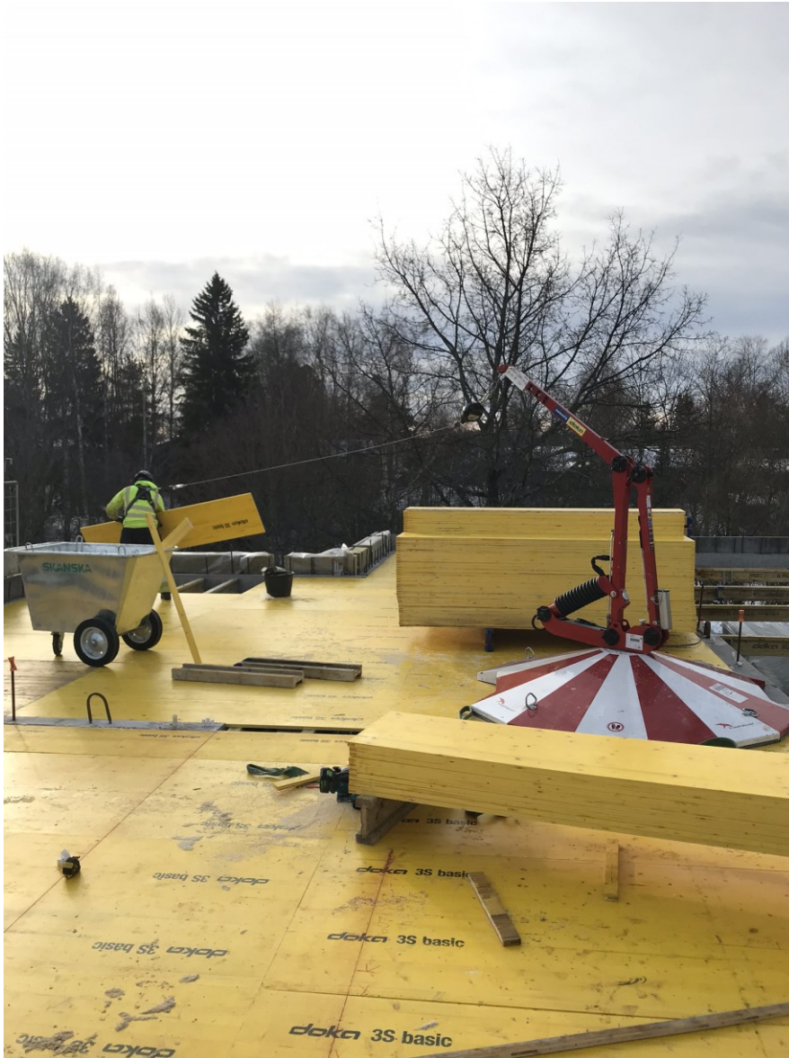
Kuva 10. Freefalcon muottikirvesmiehen käytössä.
