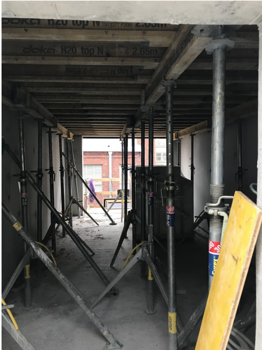
Kuva 13. Välitolpat asennettuna valua varten
