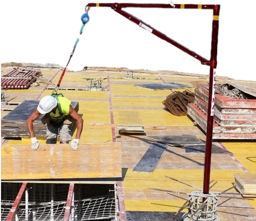
Kuva 9. Alsipercha hirsipuun toimintaperiaate [6.]
