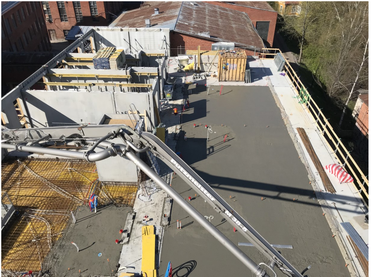
Kuva 17. Betonointityö käynnissä pumpulla.
