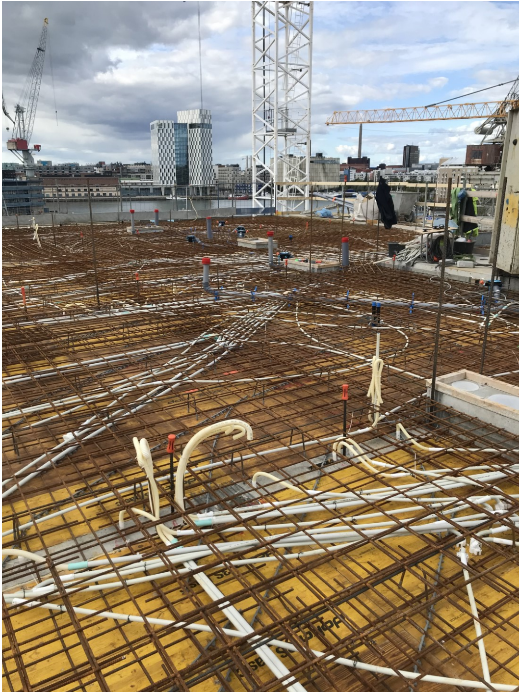
Kuva 16. Betonointia vailla oleva välipohja.
