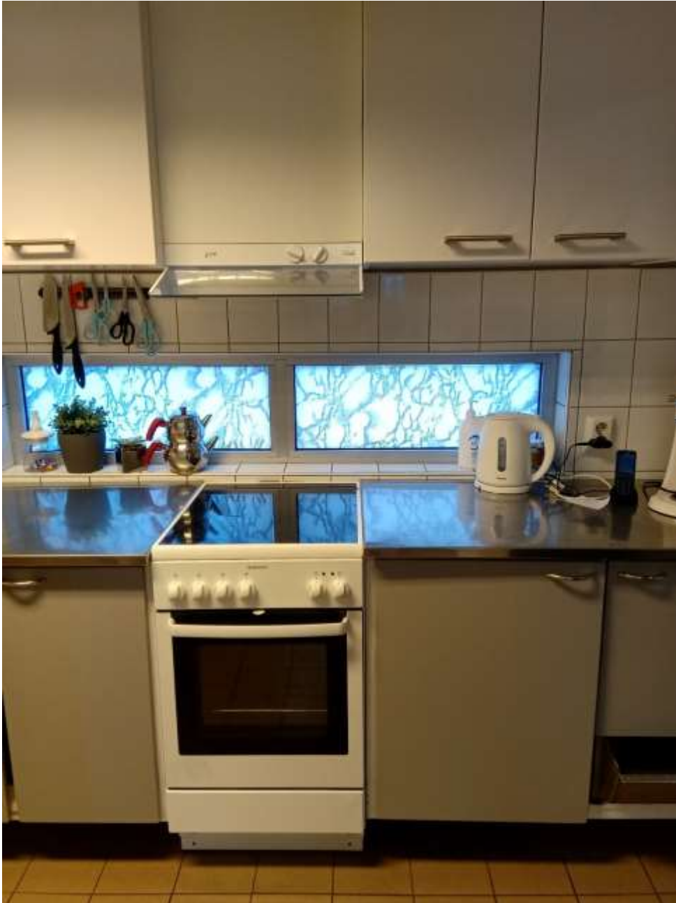
KUVA 26. Keittiön liesi ja liesikupu
