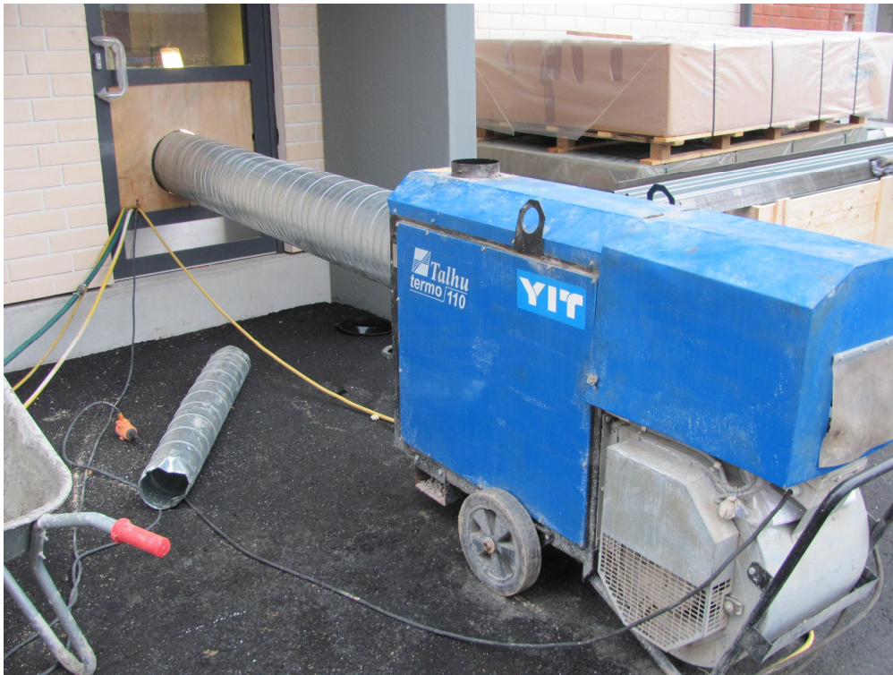
Kuva 1. Talhu Termo 110, jonka ilmanpuhallusmäärä on 5500 m 3 /h (Talhu Oy 2012).
