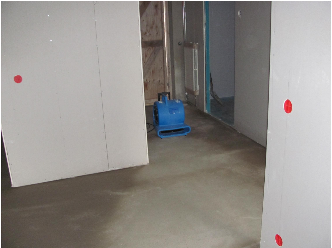
Kuva 31. Luhtitaloissa työajan ulkopuolella lämmitettiin rakenteita ja työaikana tuuletettiin simpukkapuhaltimilla (puhaltimen teho on 850 W) ja yleisellä huoneistojen läpivetotuuletuksella. Simpukkapuhaltimia käytetään myös kerrostalon lämpimän ilman jakamiseen kerroksissa (Mustonen 2012).
