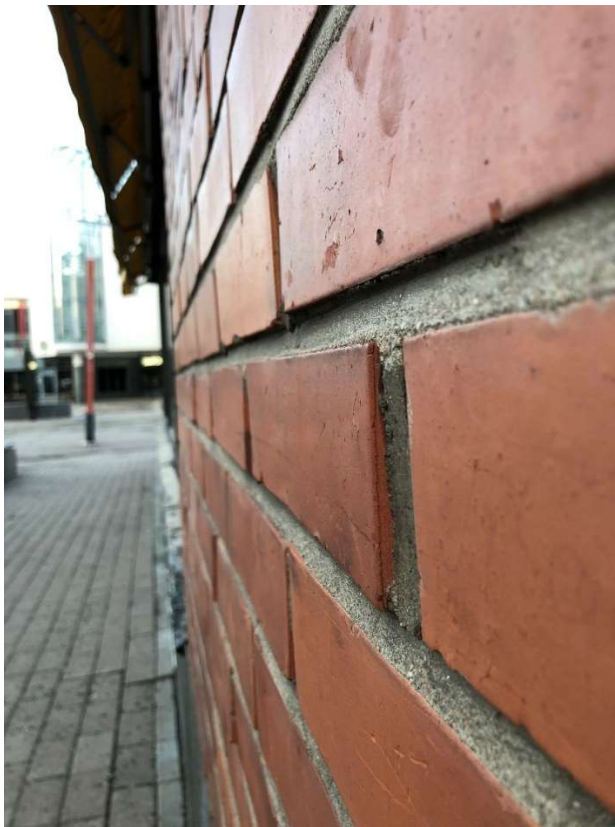
Kuva 4. Viistosti sisäänpäin vedetyillä rimoilla saumattu julkisivupinta
