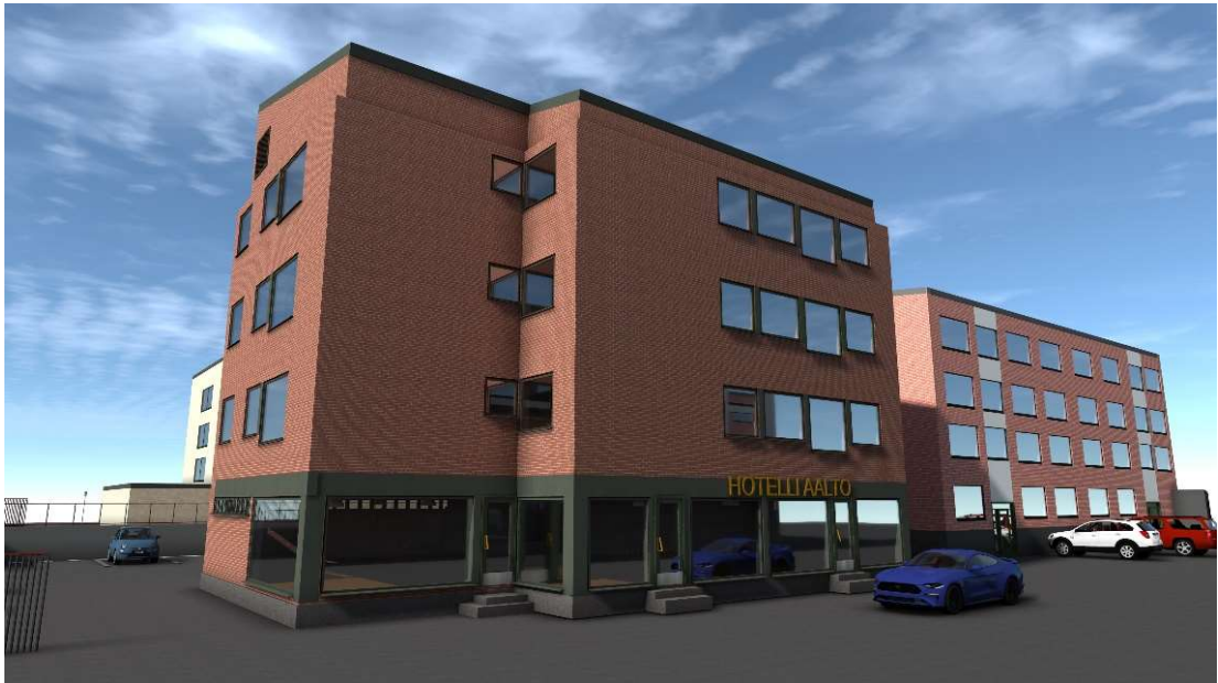
Kuva 27. Eri pintamateriaaleilla saadaan tiilirakennusten välinen sävyero
