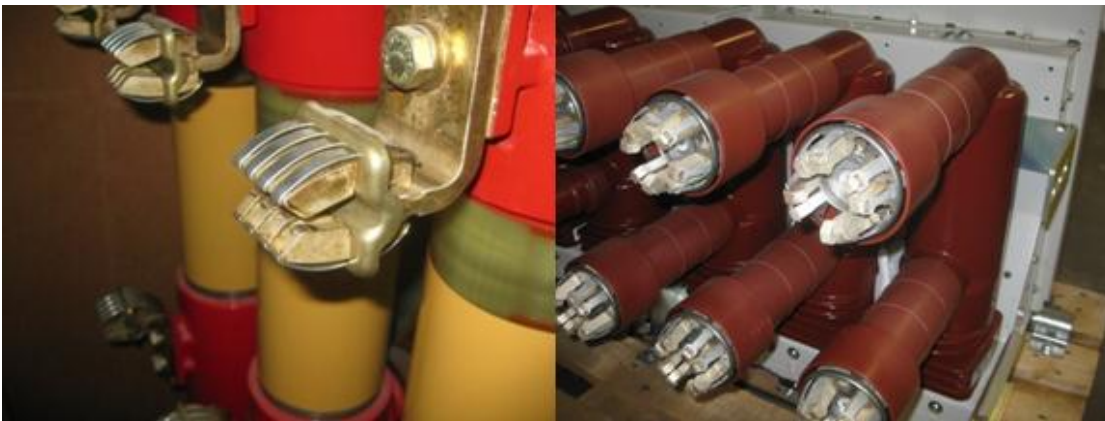
KUVA 114. OSAN- ja VD4 -katkaisijan kiskoliittimet (Sami Suhonen 2012)
