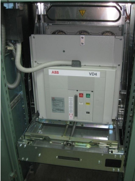
KUVA 103. Kasettiratkaisu VD4 -tyhjökatkaisijalla, SA1B1 (Sami Suhonen 2012)
