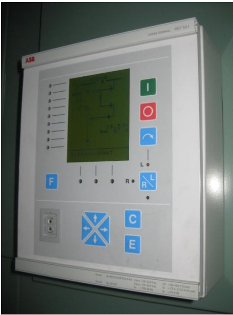
KUVA 136. ABB:n REF 541 kennotermiinaali kennon kannessa SA1B1:ssä (Sami Suhonen 2012)
