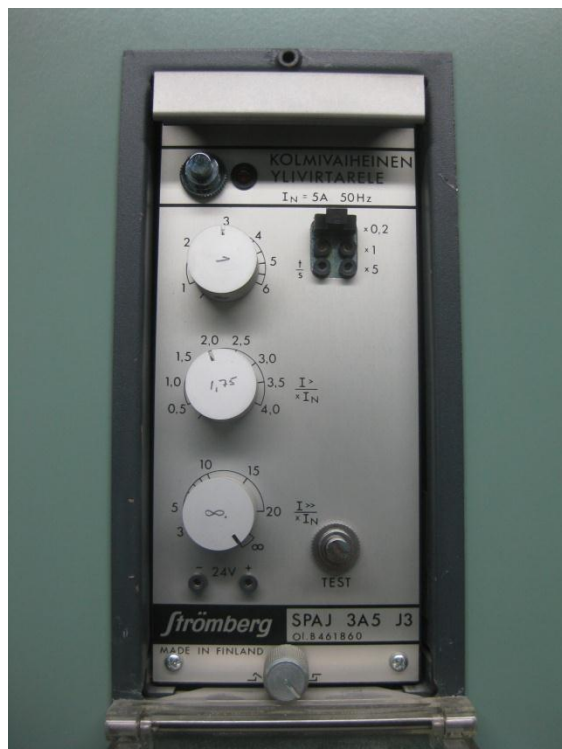
KUVA 125. Strömberg SPAJ 3A5 J3 –ylivirtarele kennon kanssa (Sami Suhonen 2012)
