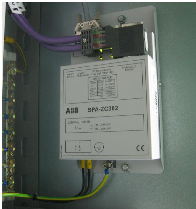
KUVA 18. SPA-ZC-302-väyläliityntämoduli, SA1B1 (Sami Suhonen 2012)
