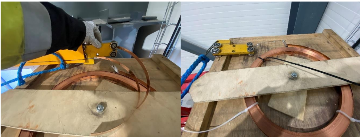
KUVA 4. Kuparin asennus virtalinjakoteloon
