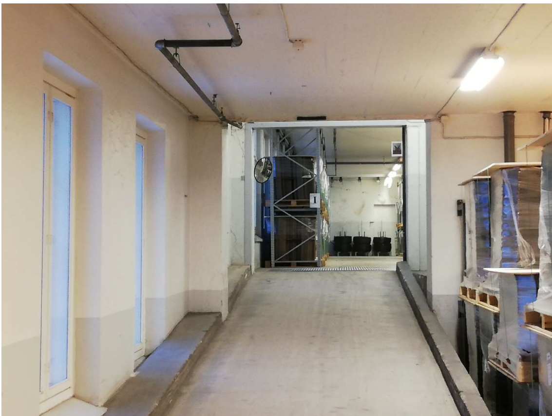
KUVA 10. Ramppi ja matala kulkuaukko asiakkaan tiloissa
