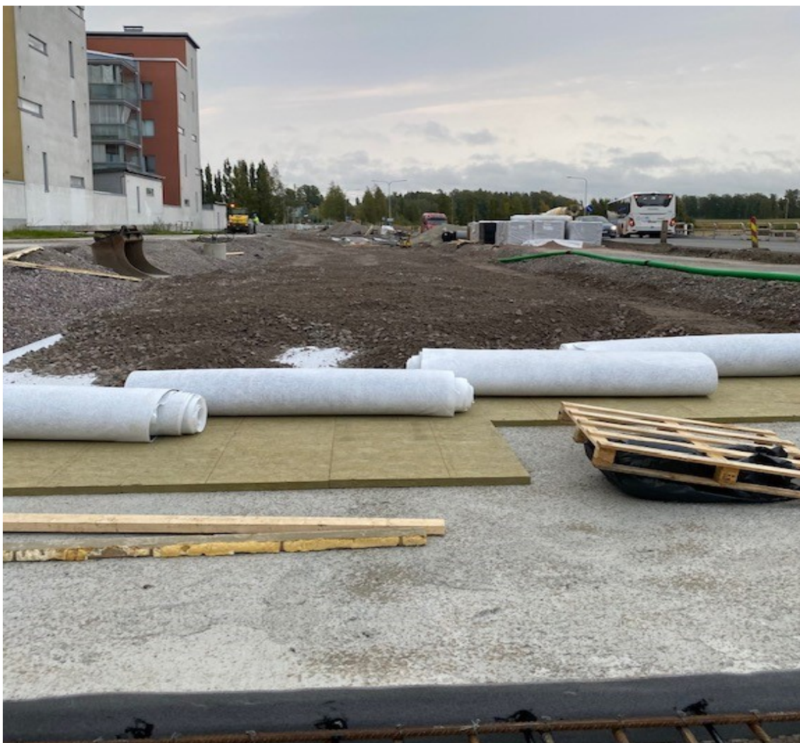
Kuva 17. Ladottua runkomelueristevillaa
