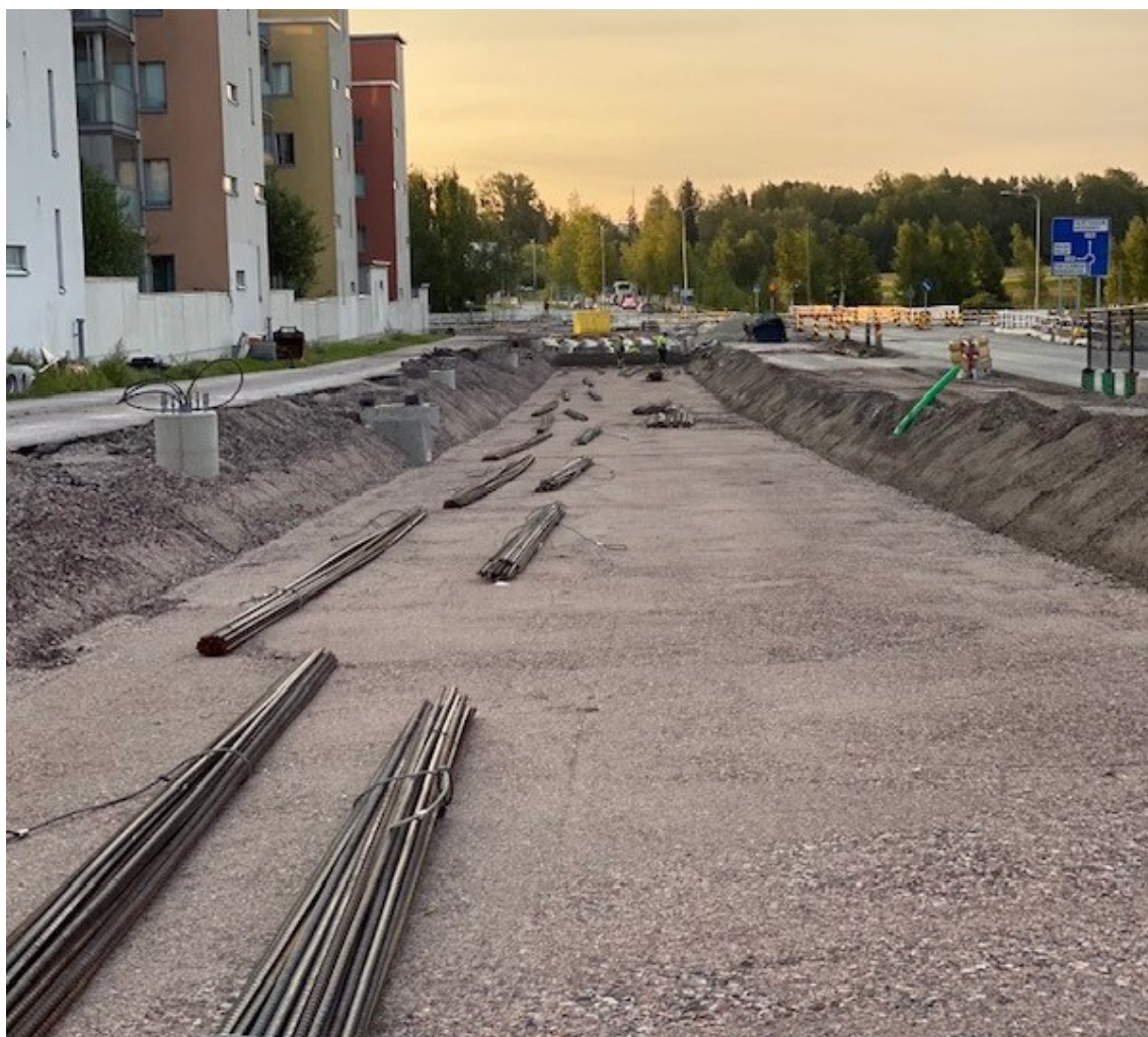
Kuva 13. Teräsbetoni-laatan teräkset valmiin eristyskerroksen päällä.
