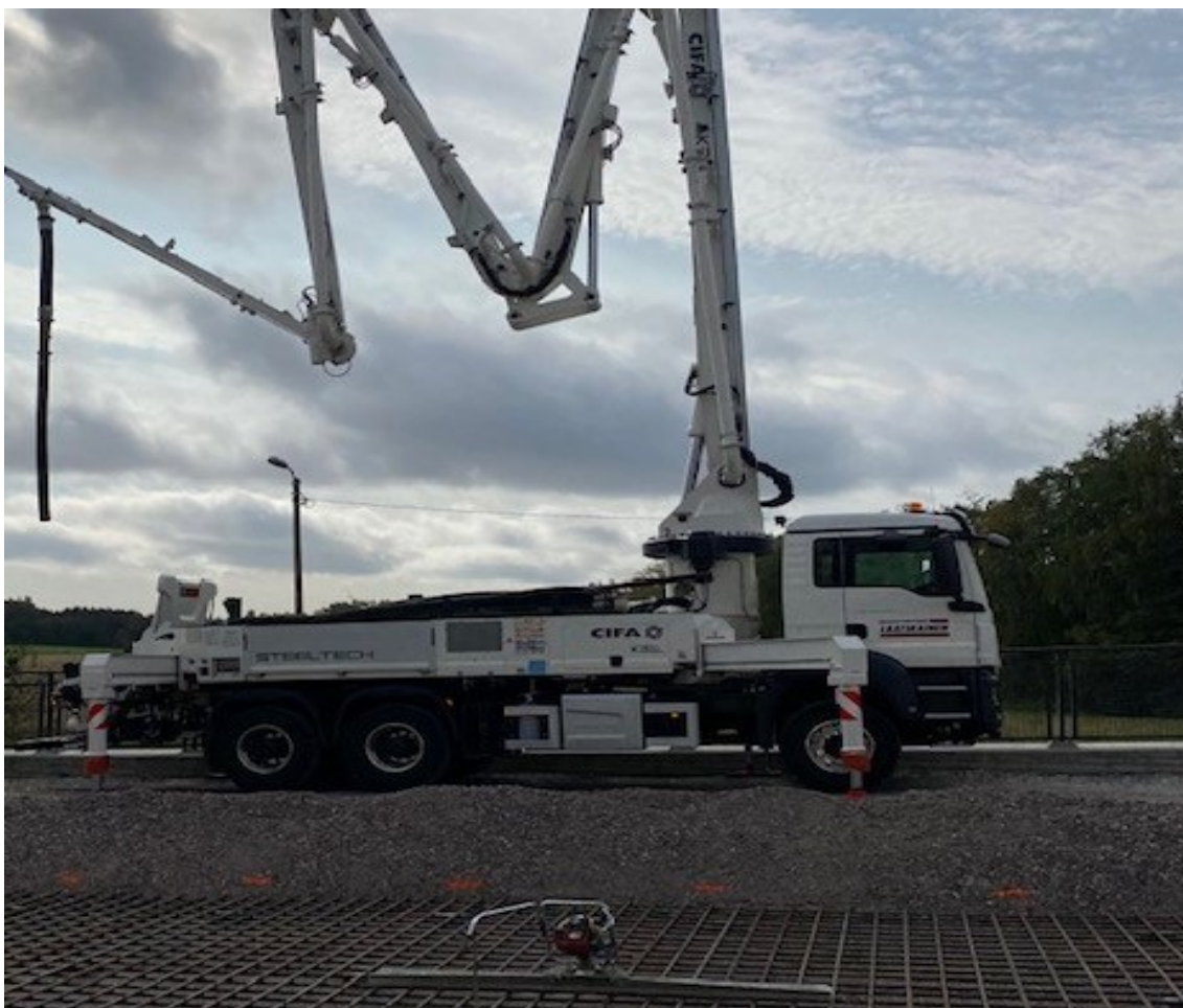
Kuva 16. Teräsbetoniilaatan yläpinnan korko, betonipumppu ja moottorikäyttöinen tärypalkki.
