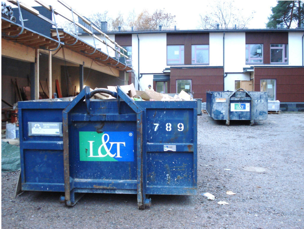
Kuva 5. Puu- ja rakennusjätelavat, As Oy Helsingin Yliskylänpuisto
