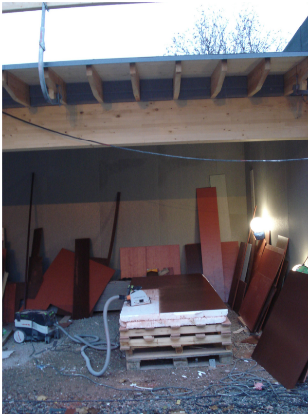
Kuva 10. Kirvesmiehen työalue on sijoitettu autokatokseen, As Oy Helsingin Yliskylänpuisto
