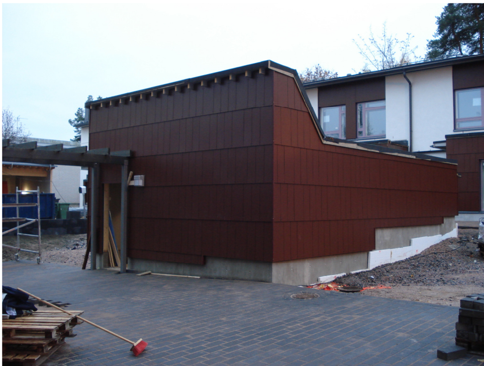
Kuva 12. Ulkoiluvälinevarasto, As Oy Helsingin Yliskylänpuisto
