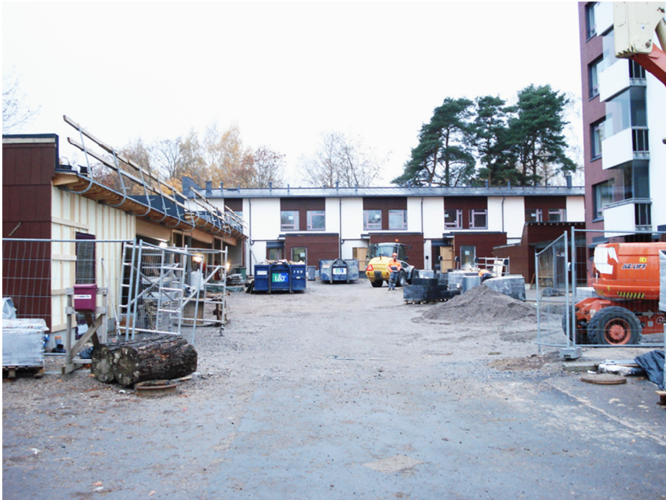
Kuva 7. Työmaan sisäänkäynti, As Oy Helsingin Yliskylänpuisto
