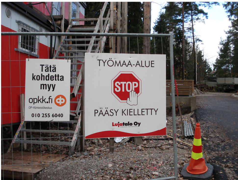
Kuva 3. Metalliverkkoaita, As Oy Vantaan Hurmekallio
