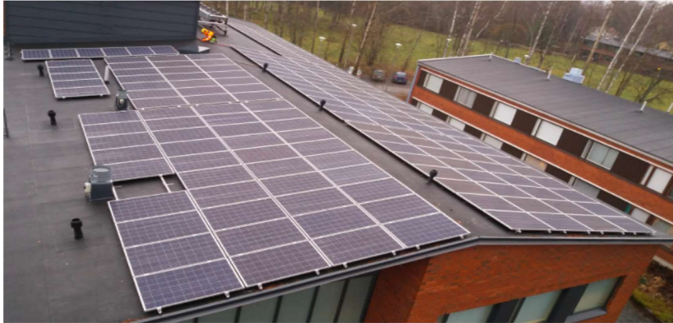
Kuva 10 Avitorin asentama vaaka asennus (Avitor 2021).
