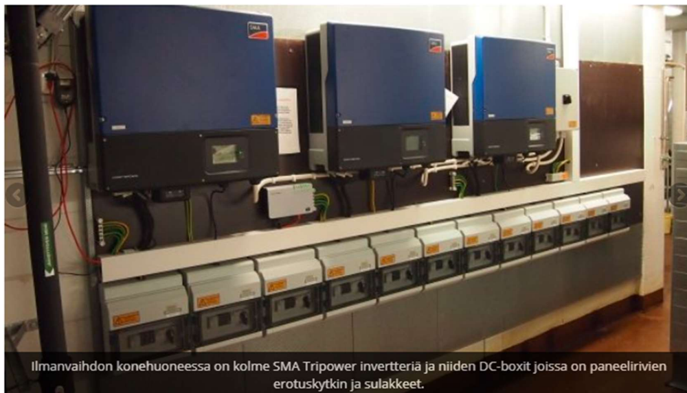
Kuva 9. Porin uimahallin invertterit (Solarforum 2011).
