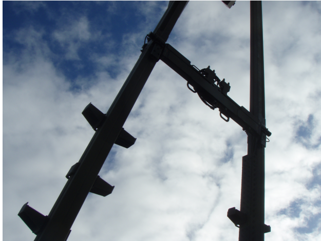
KUVIO 14. Maston tikastus ja mastovyön kiinnityspisteet
