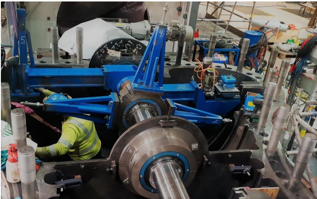
KUVA 1. Höyryturbiinin pystytiivistepintojen on-site-koneistusta
