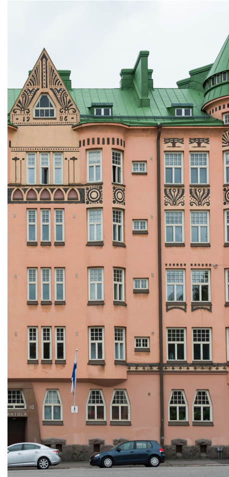
Kuva 7. Korkea huonekorkeus mahdollisti myös korkeiden ikkunoiden käytön ja teollisen tuotannon myötä ikkunoita pystyttiin valmistamaan estetiikka edellä (Kuva: Laura Honkanen)
