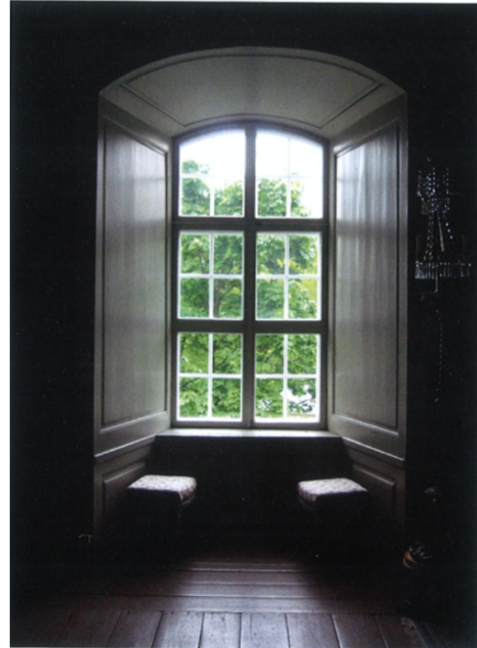
Kuva 6. 1700-luvun loppupuolella korkeat, matalalta lähtevät ikkunat tulivat muotiin. Myös ikkunanpielet maalattiin valoa heijastavain materiaalein. (Kuva: Mikkola, Böök 2011: 90)
