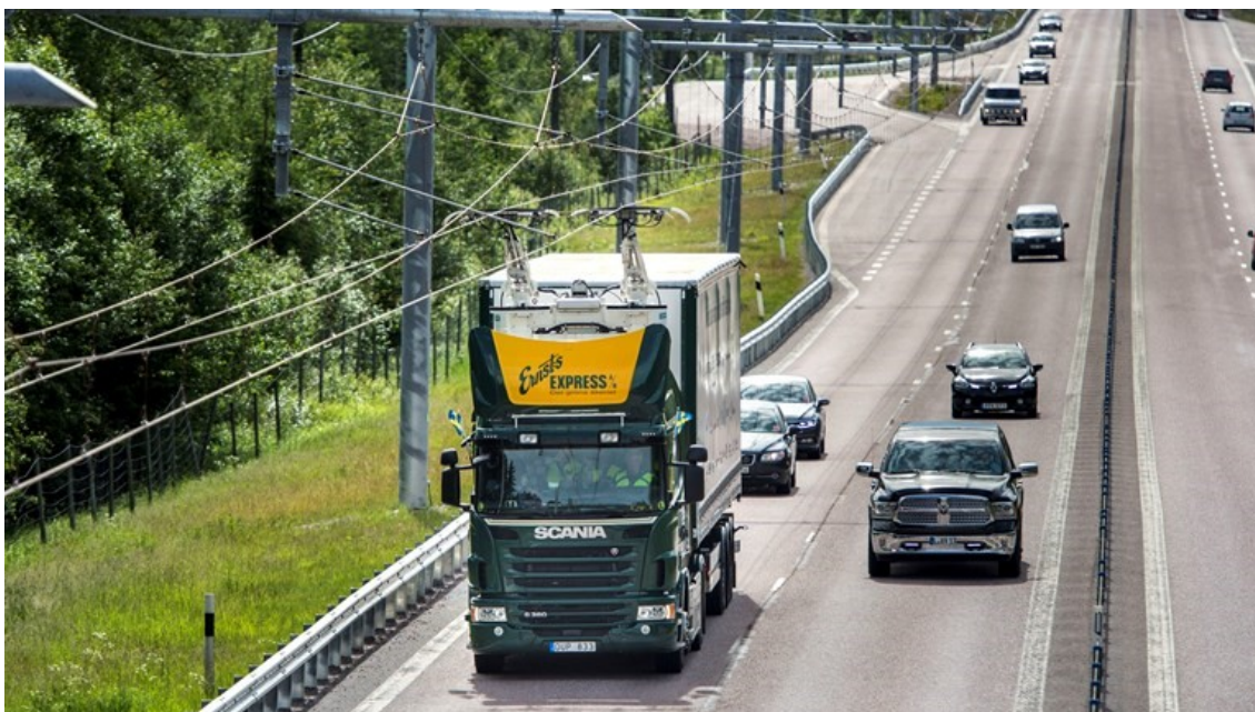
Kuva 15. Saksassa sijaitseva sähköistetty tie, jossa ajoneuvoa ladataan ajon aikana yläpuolella olevista johtimista [23].
