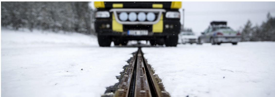
Kuva 16. Tiehen upotettu sähkökisko, jolla saadaan ladattua ajoneuvoa ajon aikana [24].
