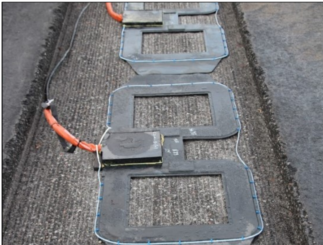
Kuva 17. Latauskäämit sijoitettuna tien alle Smart Road Gotland kokeilussa [25].
