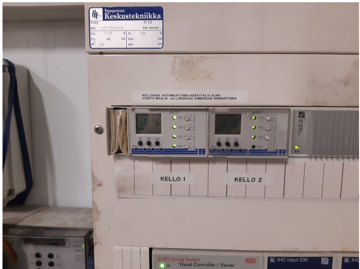
Kuva 12. IHC-tuloyksiköihin liitetyt kellokytkimet
