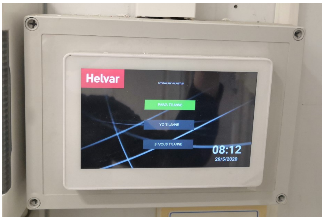
Kuva 23. Helvar SceneTouch7 -ohjauspaneeli (SceneTouch7(ST7-X)).
