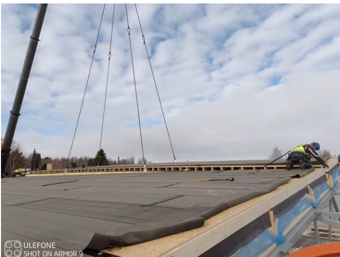
Kuva 1. Liikuntahallin kattoelementtiasennus käynnissä (SeiKat Oy 2021)
