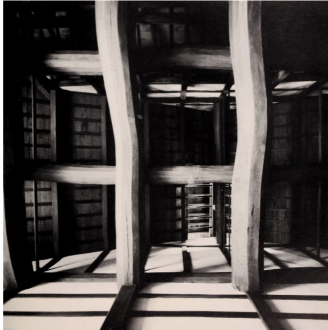
Kuva 21. Kuva minkan käyristä kattoparruista.
