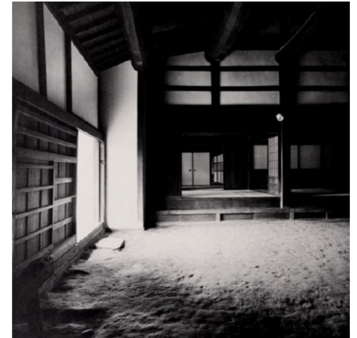
Kuva 10. Sisäkuva minkasta, maapohja ja umpinaisia saviseiniä.
