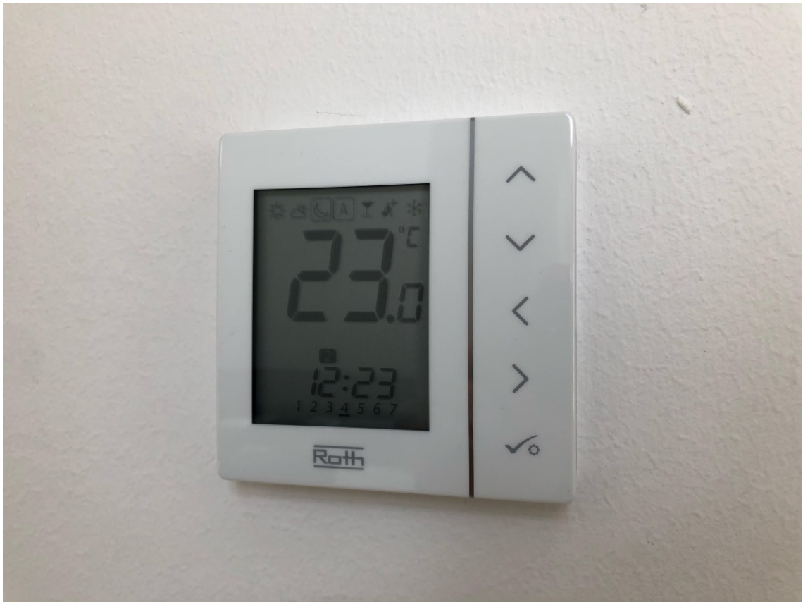
Kuva 7. Roth Basicline -huonetermostaatti langalliseen 230V:n järjestelmään asennettuna.
