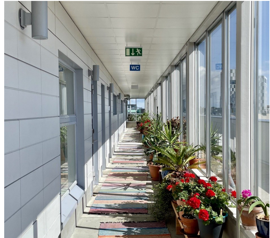
Kuva 4. Viherhuoneesta kuljetaan vasemmalla sijaitseviin saunatiloihin sekä yhteistilaan, jota voi käyttää esimerkiksi työskentelyyn tai juhlatilaisuuksiin. 39
