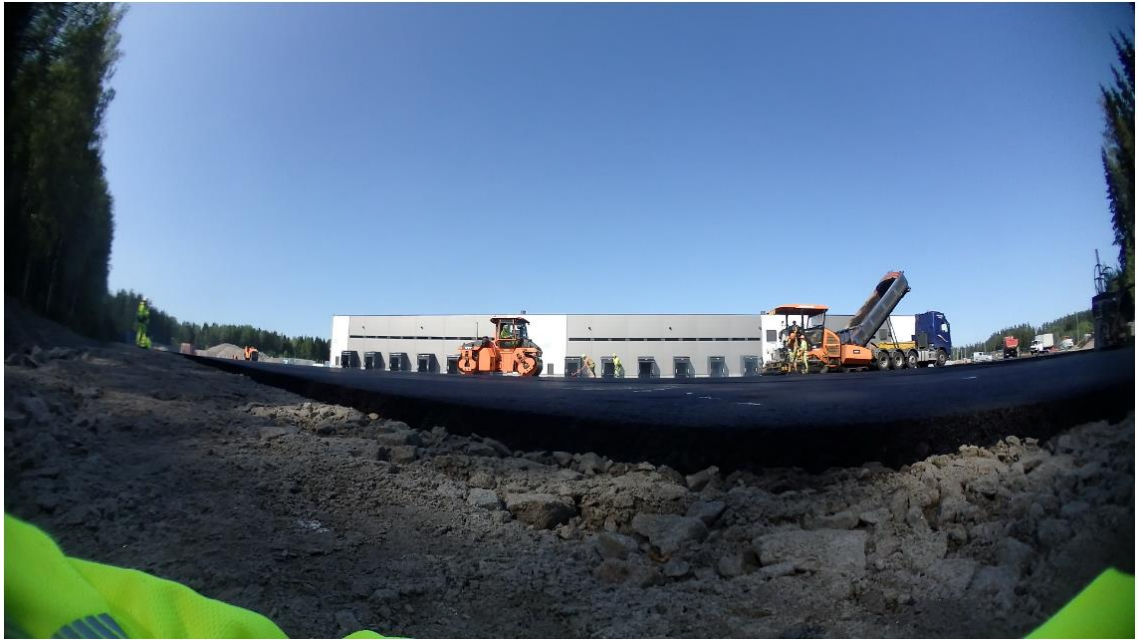
Kuva 5. kuvakaappaus työmaan videokuvasta. (Peab Industri Oy)
