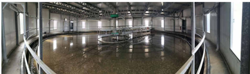
Kuva 3 Esiselkeytysaltaat (Perttu Pihlaja).
