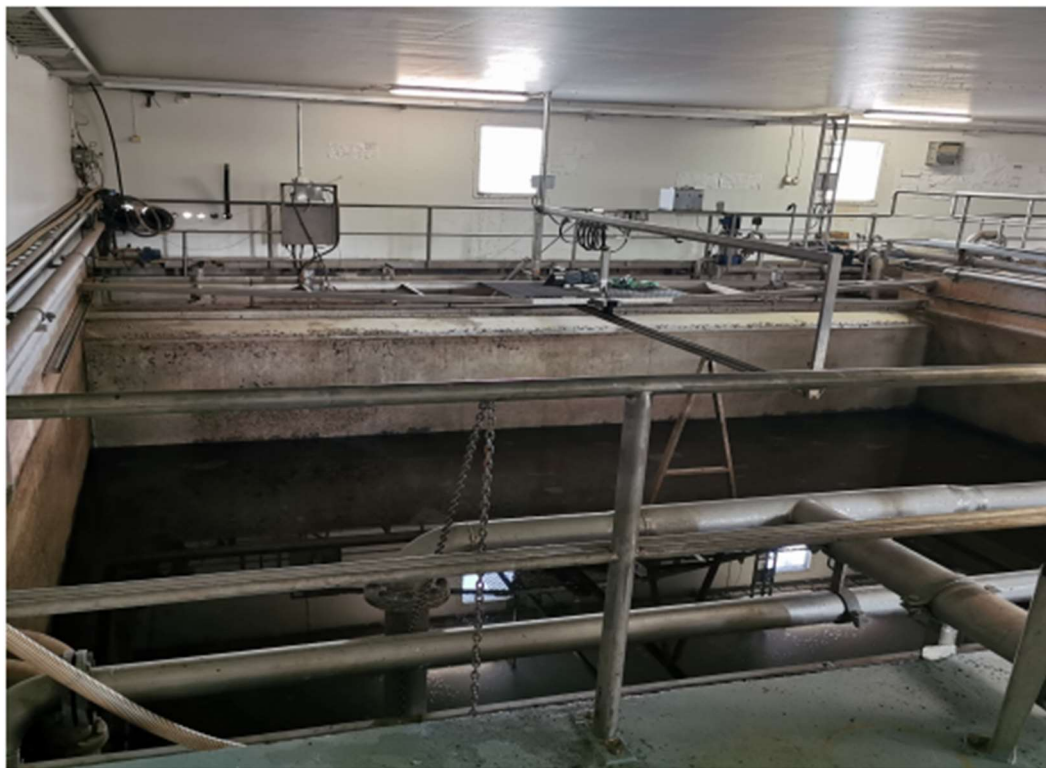
Kuva 7 Flotaatio (Perttu Pihlaja).
