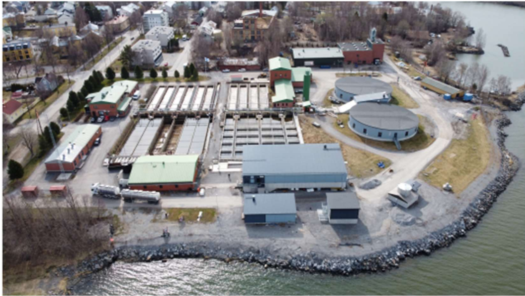
Kuva 1 Pättin jätevedenpuhdistamo (Perttu Pihlaja).
