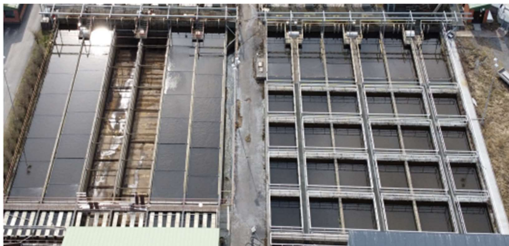
Kuva 5 Jälkiselkeytyksaltaat (Perttu Pihlaja).
